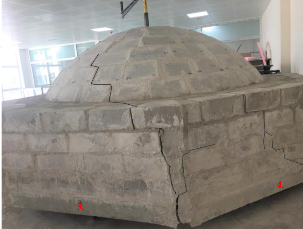
(c) 3.-4. kenarlardan başlayan çatlaklar.
