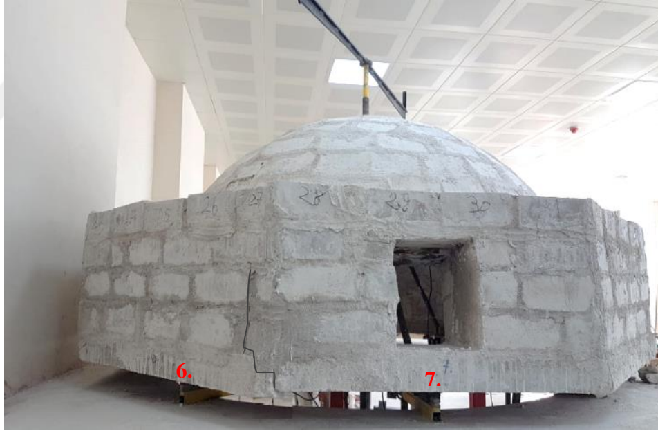
(e) 6.-7. kenarlardan başlayan çatlaklar.
