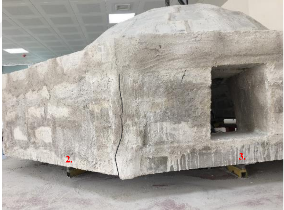
(c) 2.-3. kenarlardan başlayan çatlaklar.
