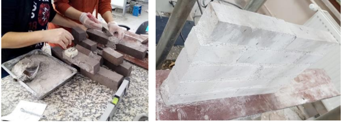
Şekil 3.5. Yığma duvar numunelerinin örülmesi.
