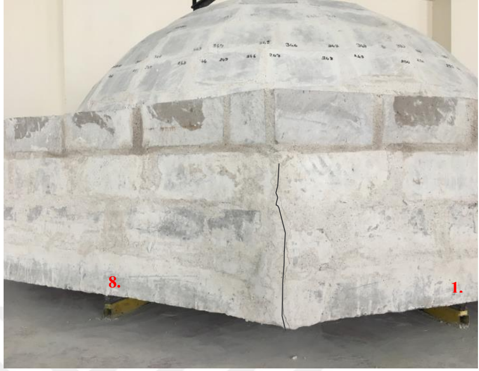
(d) 1.-8. kenarlardan başlayan çatlaklar.
