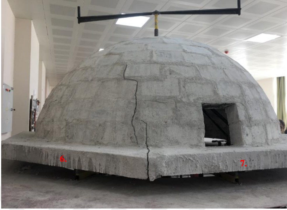
(f) 6.-7. kenarlardan başlayan çatlaklar.
