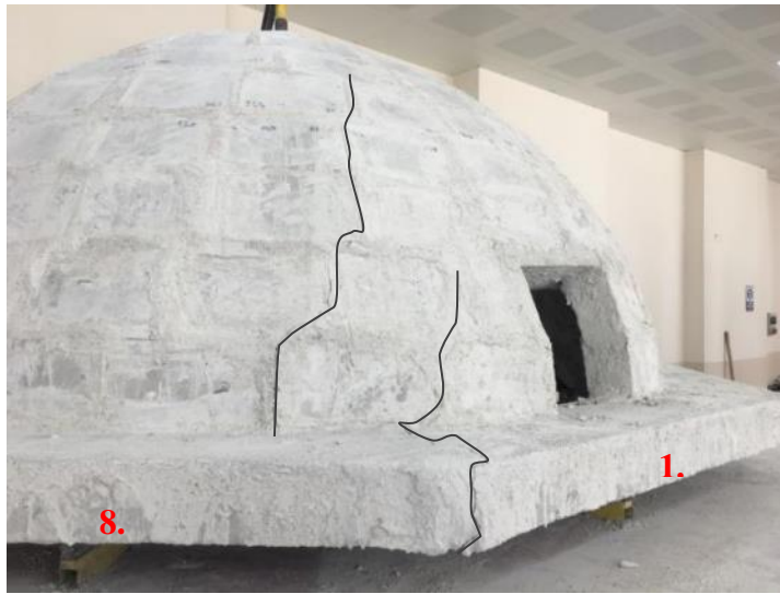
(a) 1.-8. kenarlardan başlayan çatlaklar.
