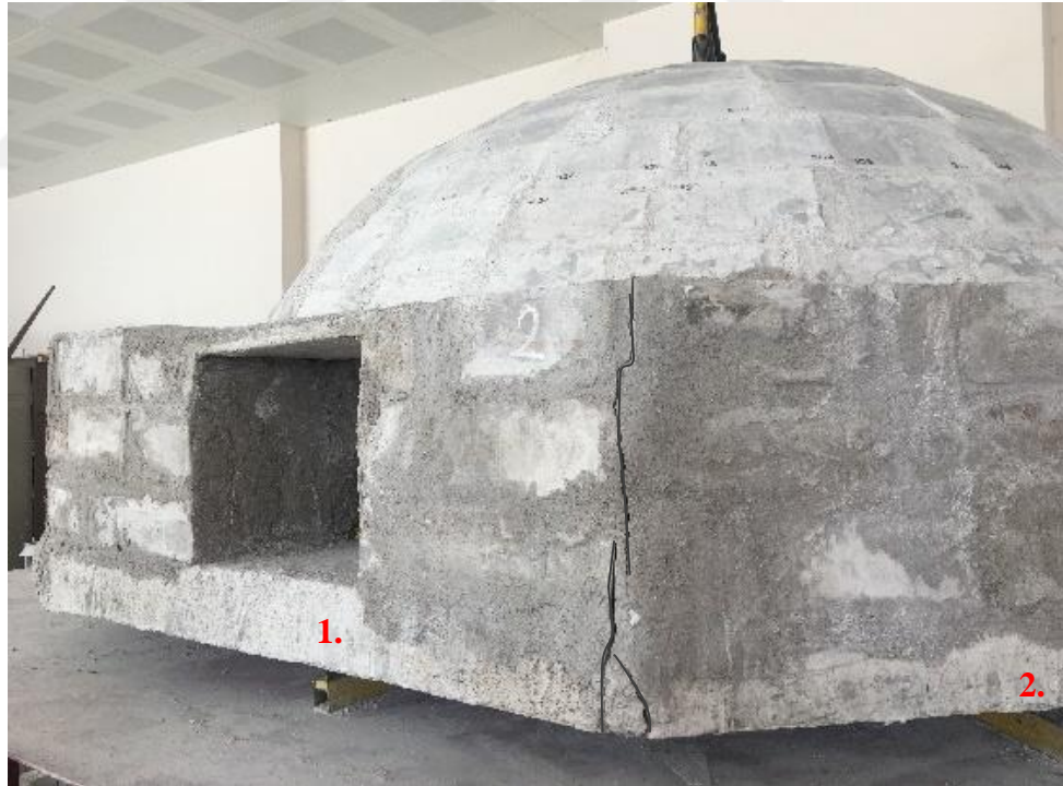
(b) 1.-2. kenarlardan başlayan çatlaklar.
