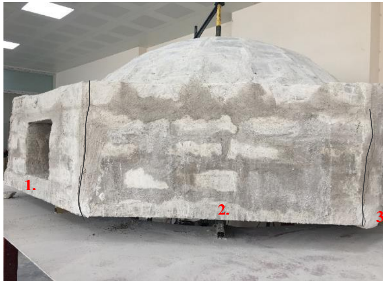
(a) 1.-2. ve 2.-3. kenarlardan başlayan çatlaklar.
