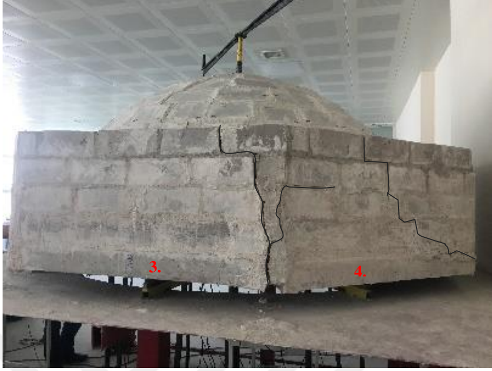
(b) 3.-4. kenarlardan başlayan çatlaklar.
