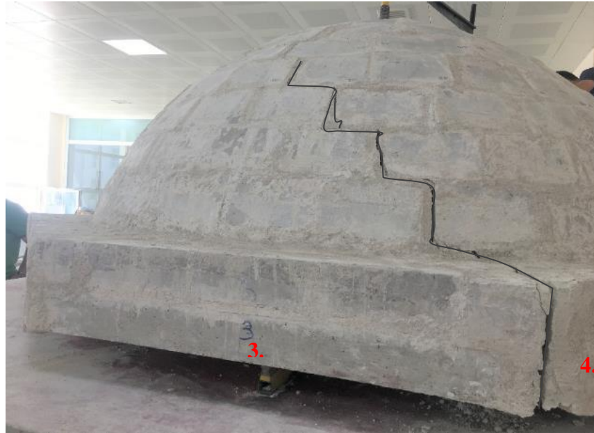
(b) 3.-4. kenarlardan başlayan çatlaklar.
