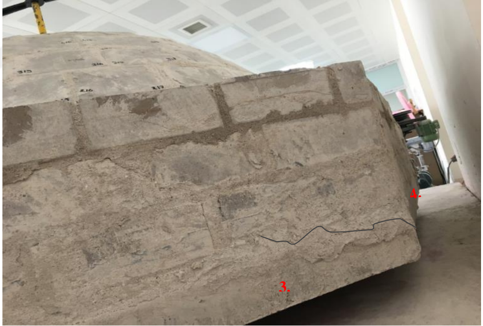
(c) 3.-4. kenarlardan başlayan çatlaklar.
