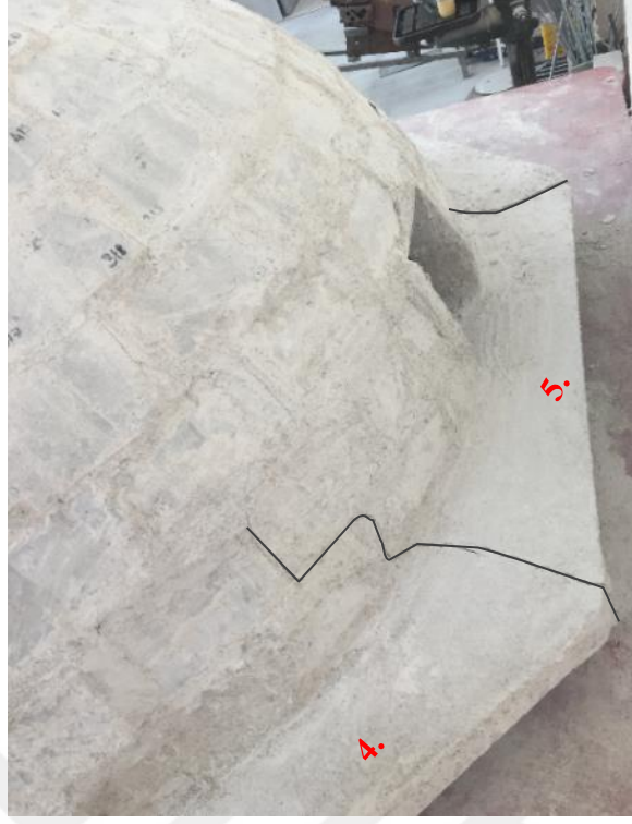
(d) 4.-5. kenarlardan başlayan çatlaklar.
