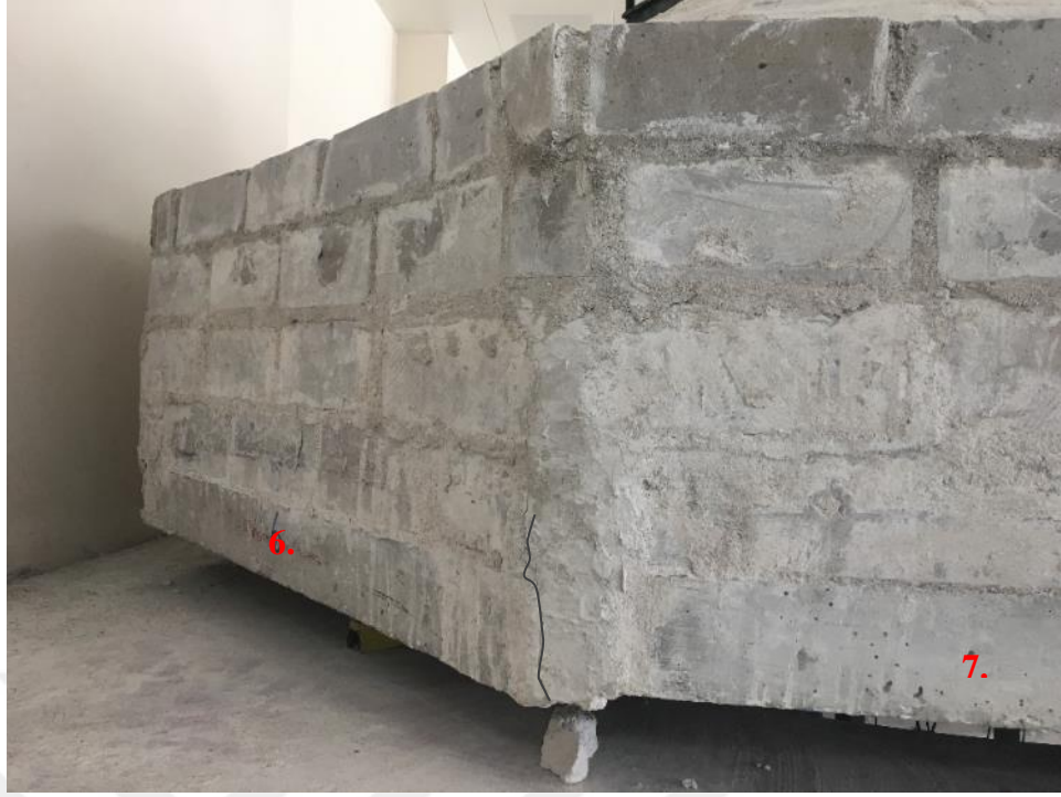
(d) 6.-7. kenarlardan başlayan çatlaklar.
