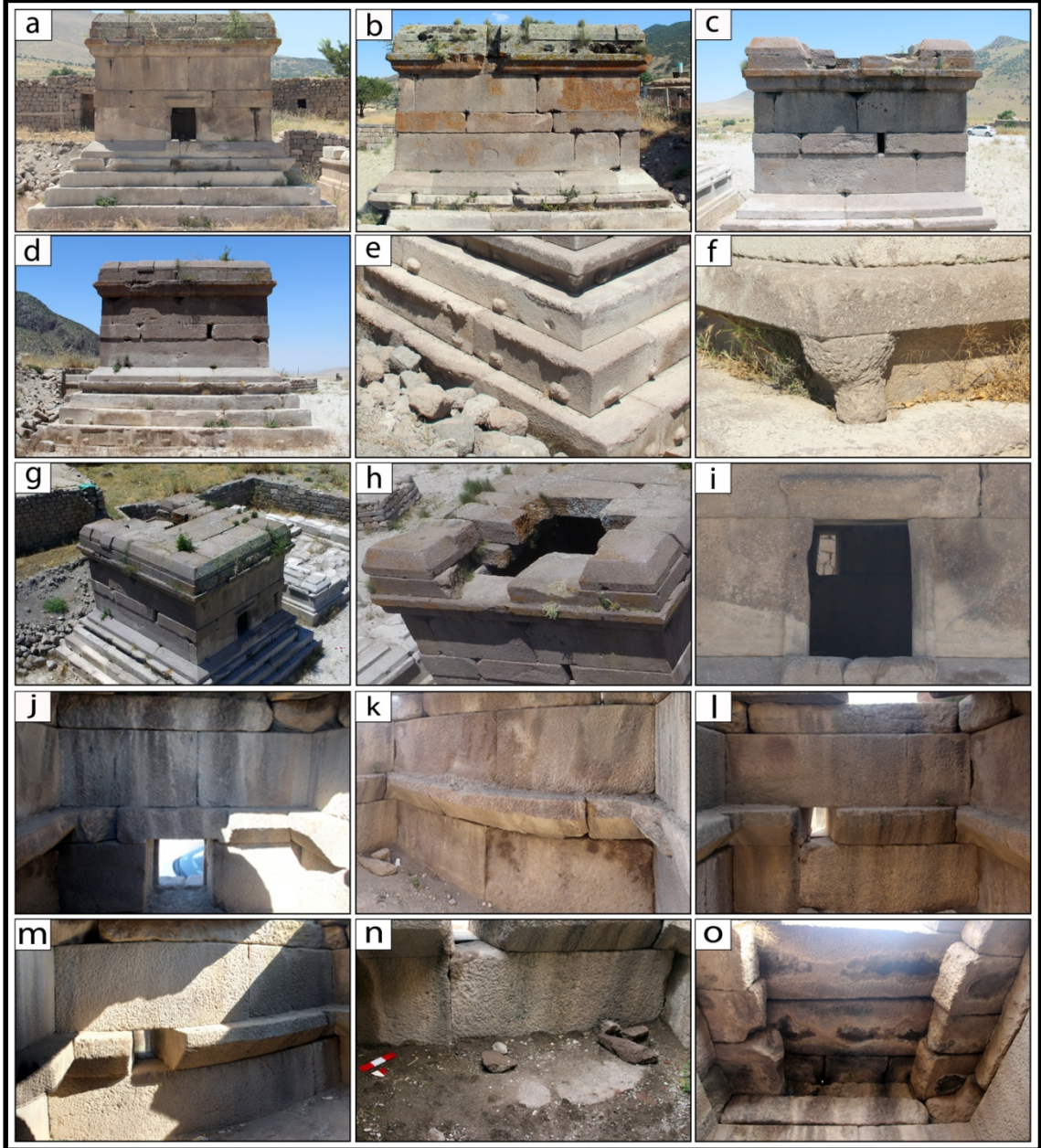
Şekil 4.5. Anıt mezarın cephe ve iç mekân görünüşleri ile detayları; a) kuzeydoğu cephesi, b) kuzeybatı cephesi, c) güneybatı cephesi, d) güneydoğu cephesi, e) “Tenon” adı verilen çıkıntılar, f) stilize bitkisel figürlerle süslenmiş ayaklar, g) üst yapı sistemi, h) güneybatı cephesindeki eksik bloklar ile köşelerde yer alan kaideler, i) mezarın giriş kapısı, j) kuzeydoğu duvarı, k) kuzeybatı duvarı, l) güneybatı duvarı, m) güneydoğu duvarı, n) toprak dolgu zemin, o) taş konsollar ve bindirme tavan.
