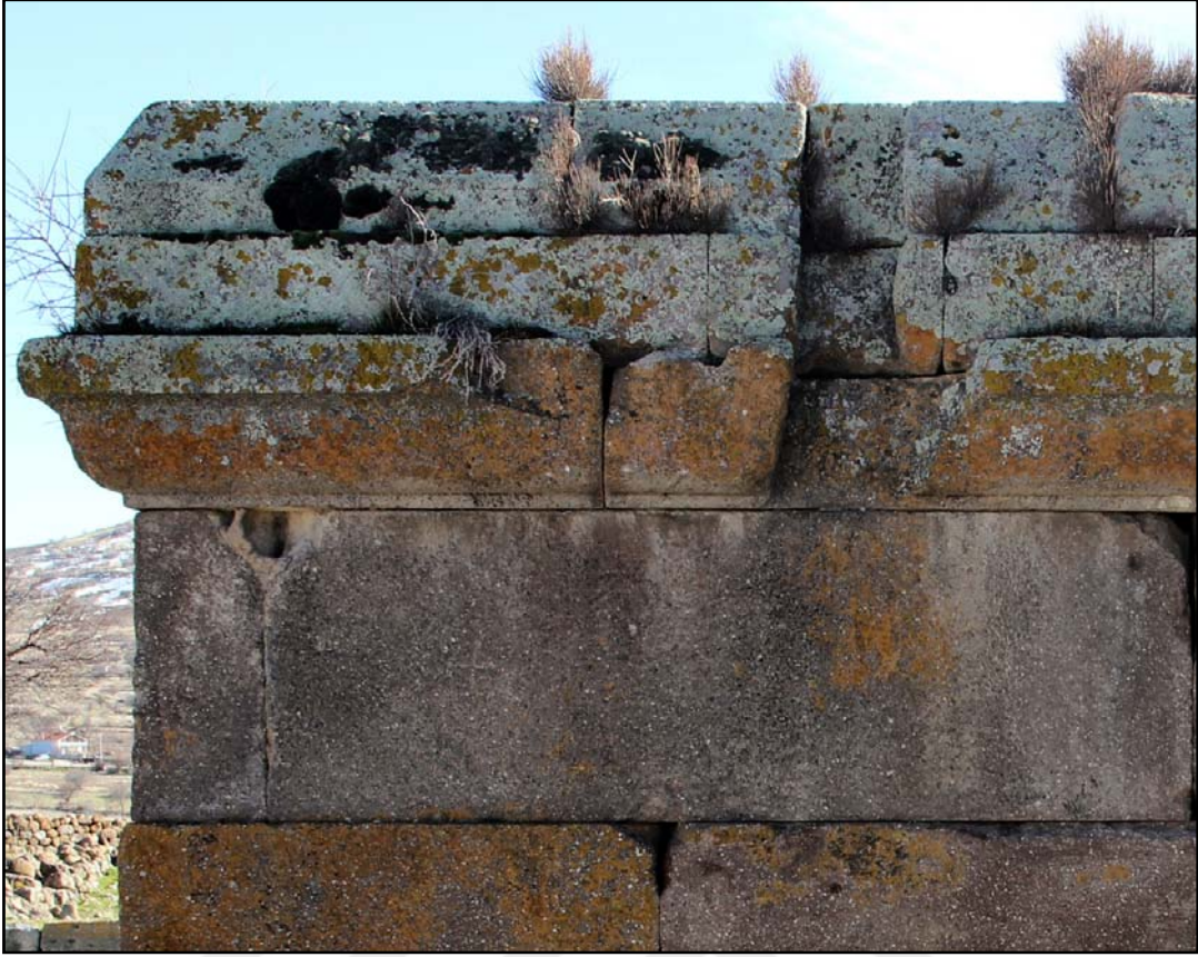
Şekil 5.15. Üst örtü bloklarında gözlenen süzülme zonu.
