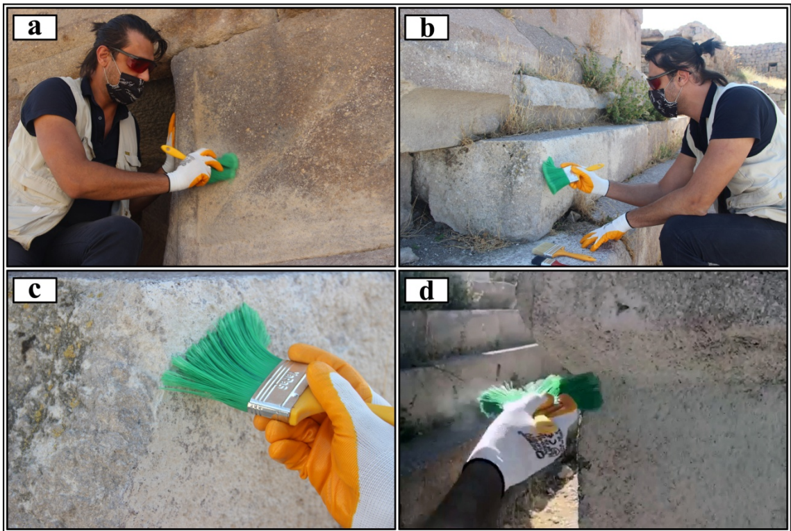
Şekil 6.2. Beyaz kabuk katmanını yapı taşı yüzeylerinden temizleme uygulaması.
