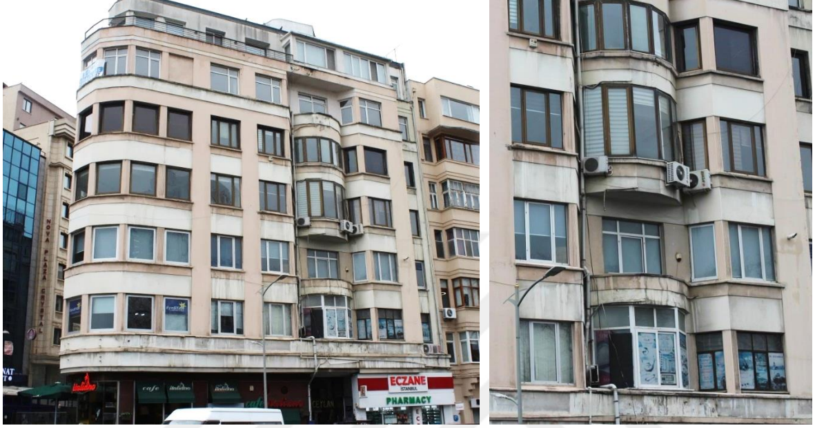
Şekil A.1: “Ceylan Apartmanı” Loca Balkon
