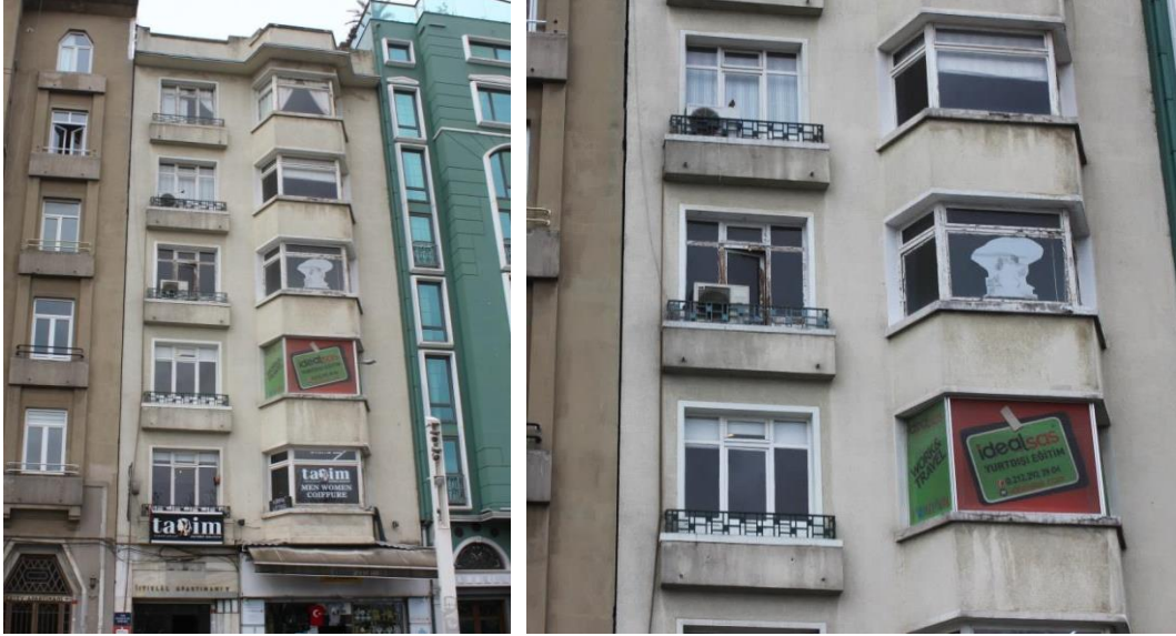
Şekil A.2: “İstiklal Apartmanı” Fransız Balkon Görünüşü
