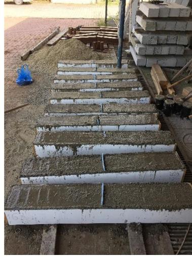
Şekil 3.19. Bazı numunelerin beton dökümünden sonraki halleri
