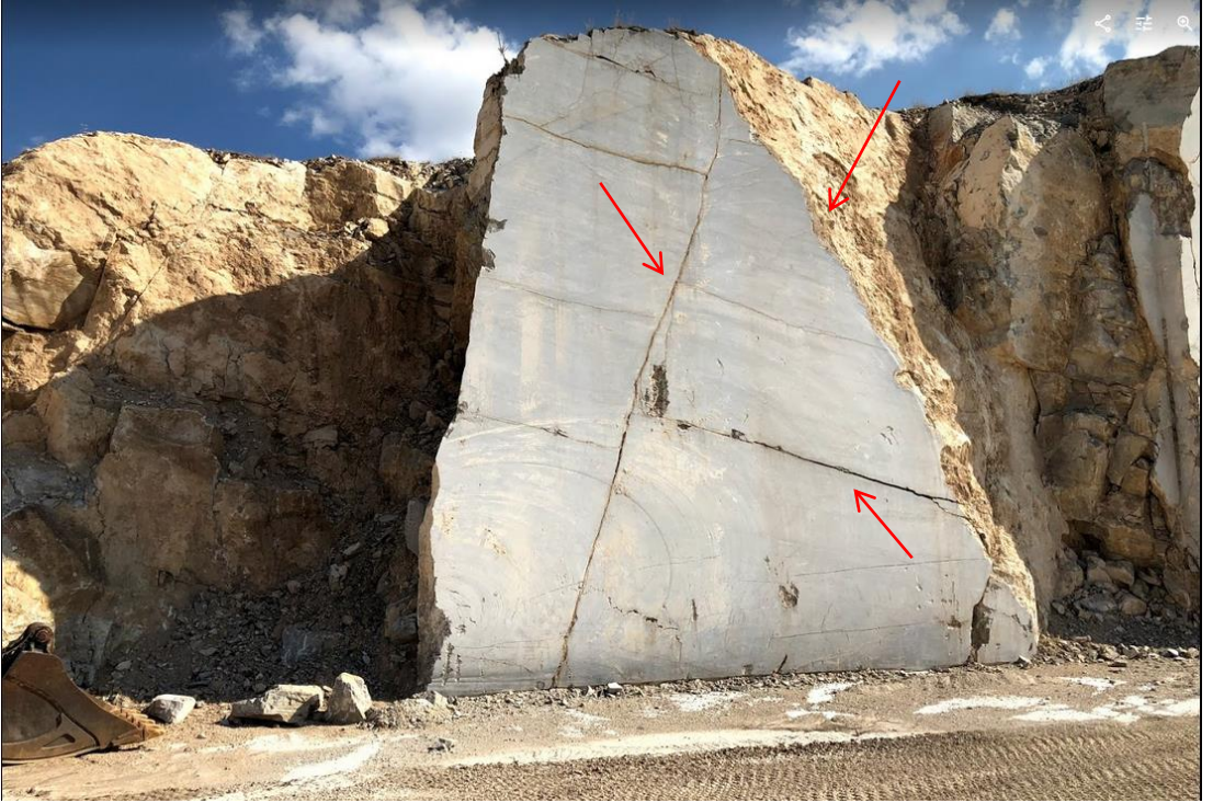
Şekil 3.15. Gri kireçtaşlarında kademelerde yaygın görülen 3 farklı konumdaki kırık sistemi
