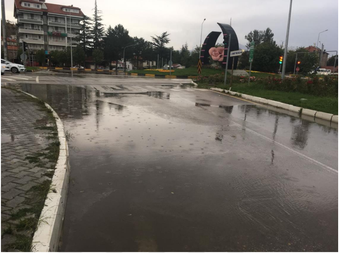
Şekil 4.12. Çünür Mahallesi Taşkın Meydana Gelen Alan 1
