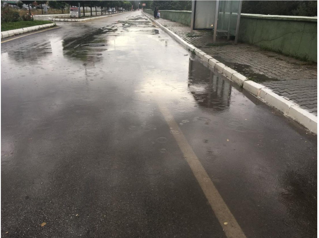
Şekil 4.13. Çünür Mahallesi Taşkın Meydana Gelen Alan 2
