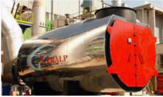
Şekil 3.41. Atık Isı Kazanı ile Buhar Türbini Detay Resmi
