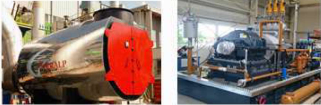
Şekil 4.23. Elektrik Üretim Bölümü – Atıkısı ile Buhar Türbini ve Jeneratörü
