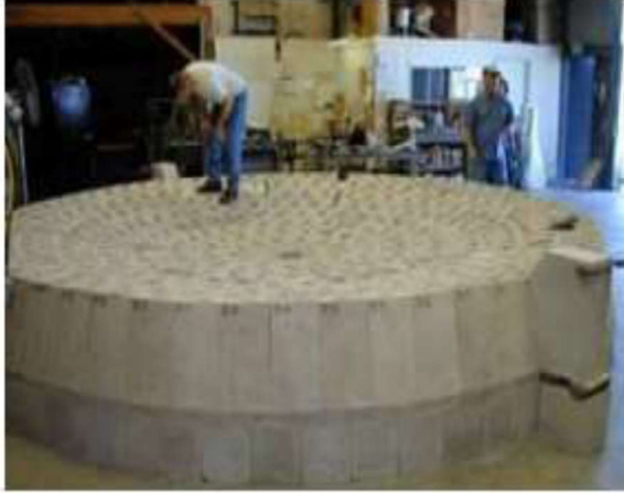
Şekil 3.28. Refraktör kemer ( Taban Çukuru ) ve kubbe
