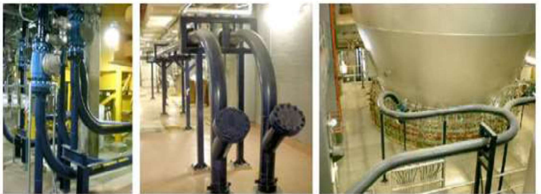
Şekil 3.40. Fırını besleyen çamur boru hatları
