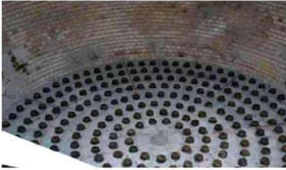
Şekil 3.31. Akışkanlaştırma Yapısı – Tuyere Detayı
