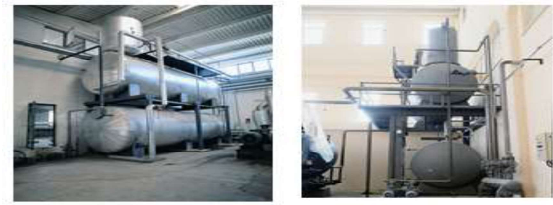
Şekil 3.43. Degazör Detay Resimleri
