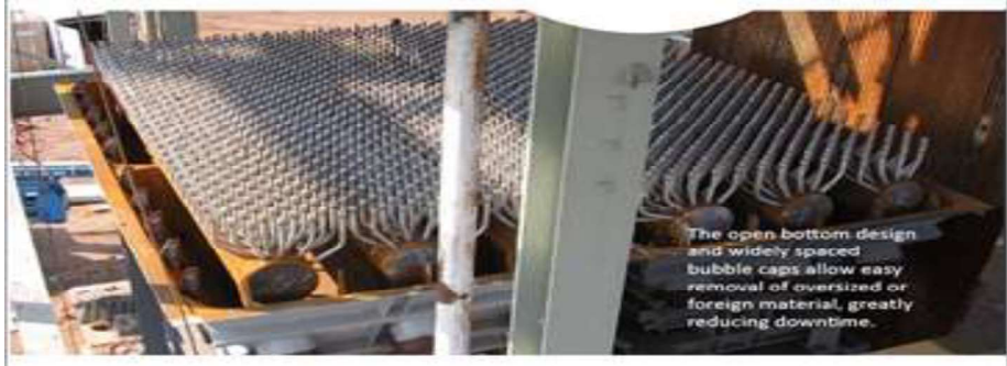
Şekil 3.19. Dolaşımli Akışkan Yataklı Kazan Detay Resmi
