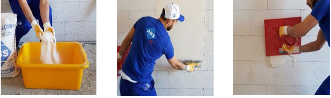
Şekil 1.8 Perlitli sıva alçısı uygulanması
