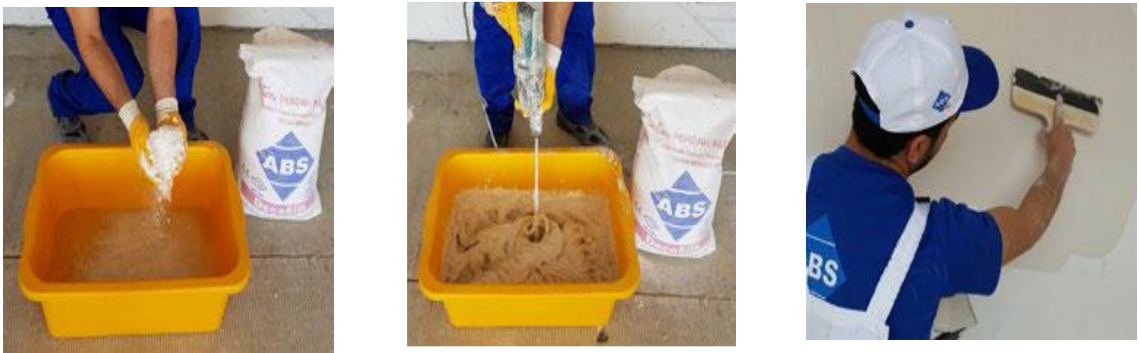
Şekil 1.9 Saten pertah alçısı uygulanması
