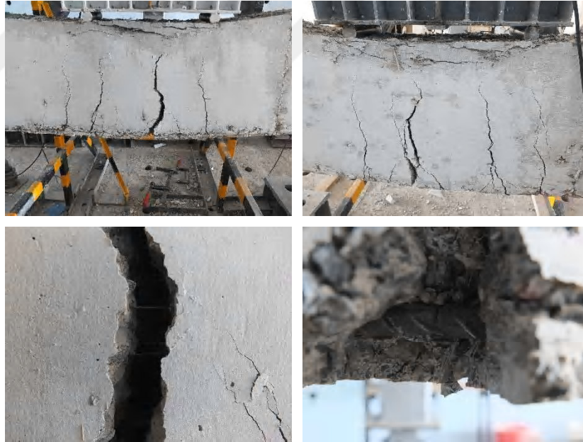
Şekil 3.59. No.9 kirişi hasar oluşumu
