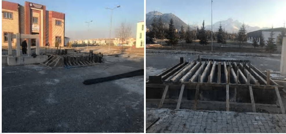
Şekil 2.8. Kalıpların hazırlanması
