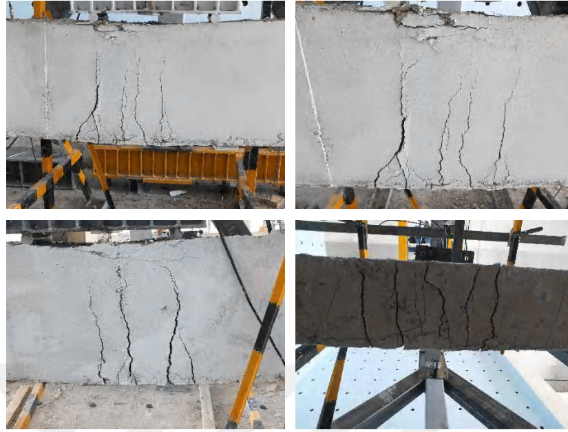
Şekil 3.94. No.14 kirişinin hasar oluşumu
