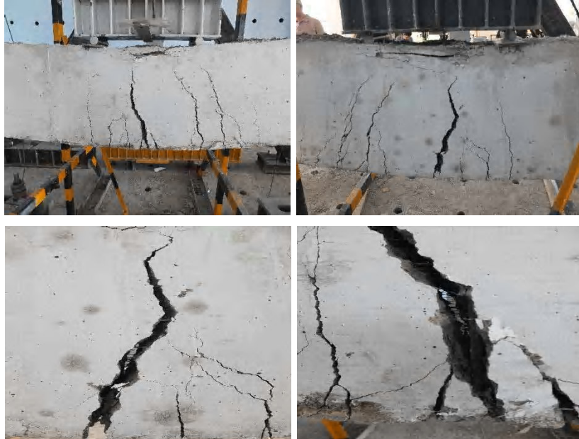
Şekil 3.24. No.4 kirişi hasar oluşumu
