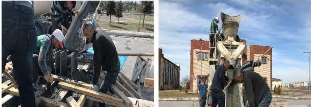
Şekil 2.11. Beton dökümü ve vibratör uygulaması
