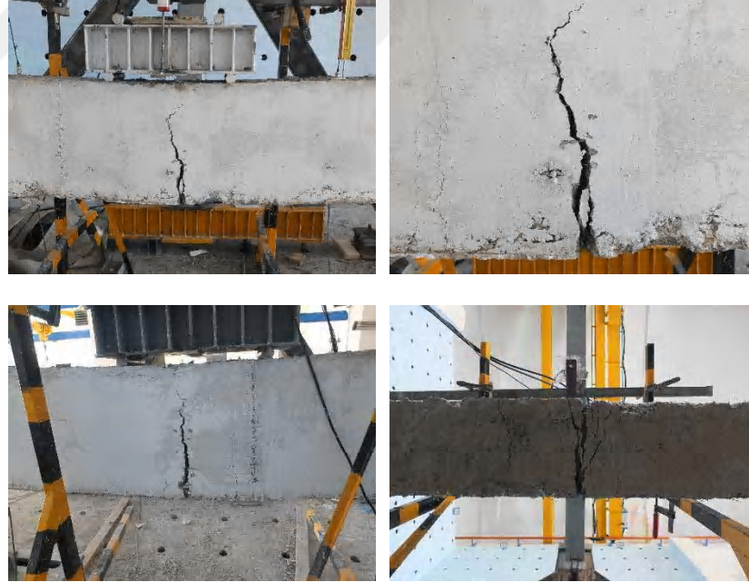
Şekil 3.80. No.12 kirişi hasar oluşumu
