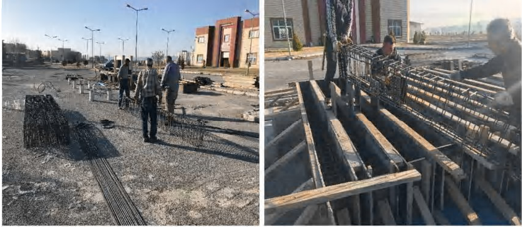
Şekil 2.10. Donatıların kalıp içerisine yerleştirilmesi
