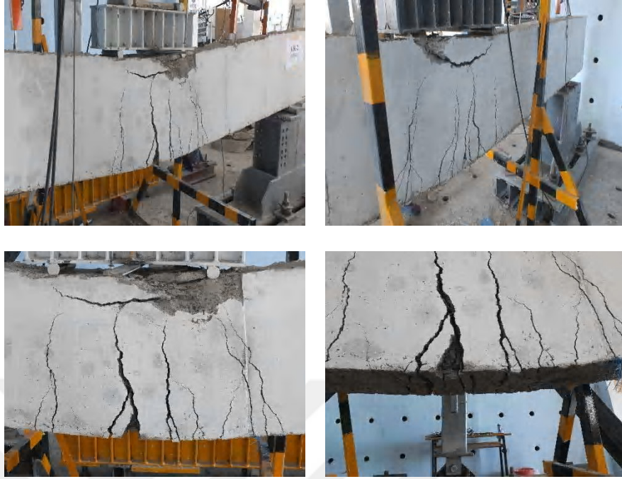
Şekil 3.10. No.2 kirişi hasar oluşumu
