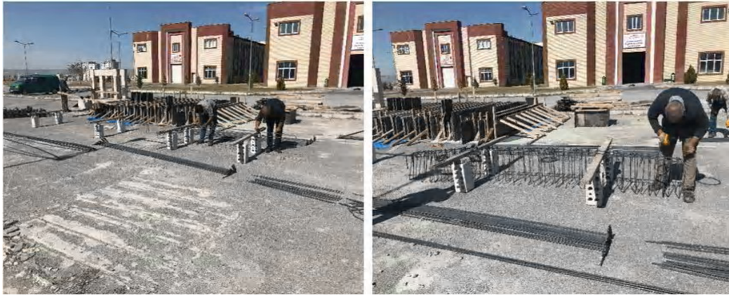
Şekil 2.9. Donatıların hazırlanması
