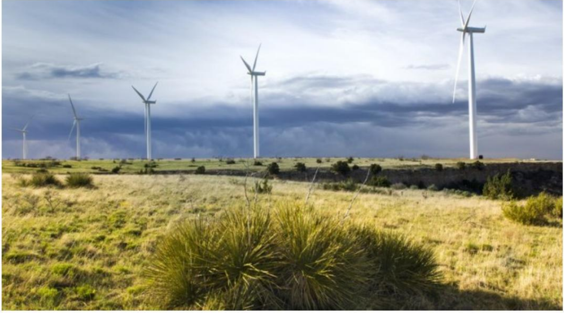
Şekil 5.16. Rüzgâr enerjisi çiftliği (Rüzgâr Enerjisi Tarlası) (Anonim,2019c.)
