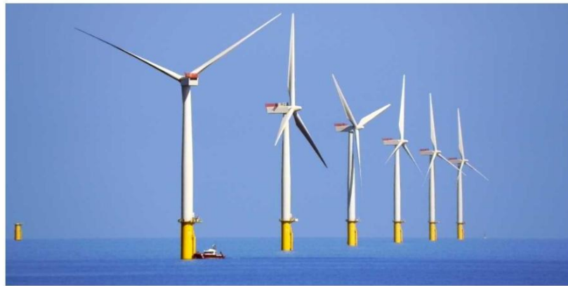
Şekil 5.6. Yatay eksenli rüzgâr türbinlerinden oluşan RES (Anonim,2019c)
