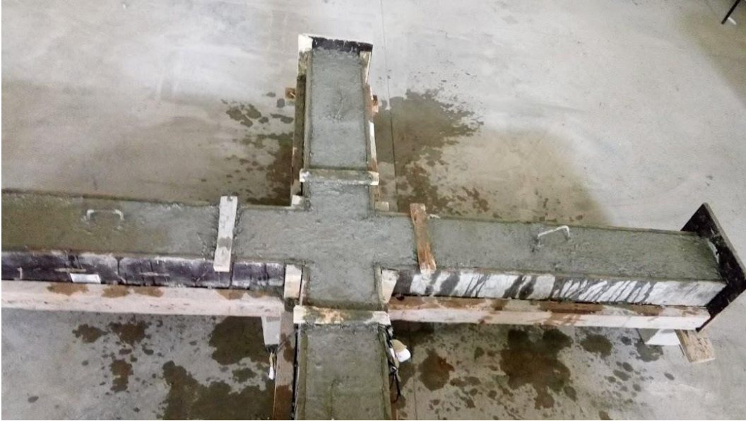
Şekil 3.13 Beton dökümünden sonra deney elemanları
