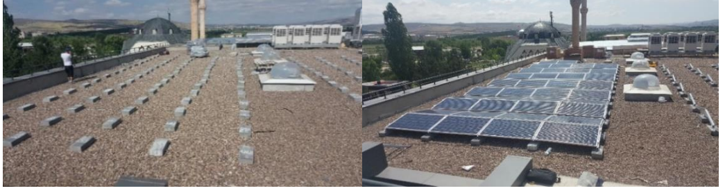
Şekil 6.9. Düz çatıda ağırlık kullanım uygulaması.(Günder, 2018)
