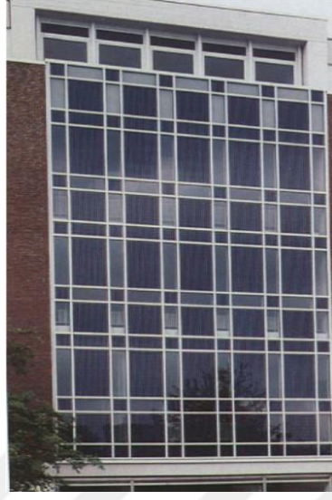
Şekil 6.33. Büro Binası – Aachen, Almanya. (Kılıç, 2011)
