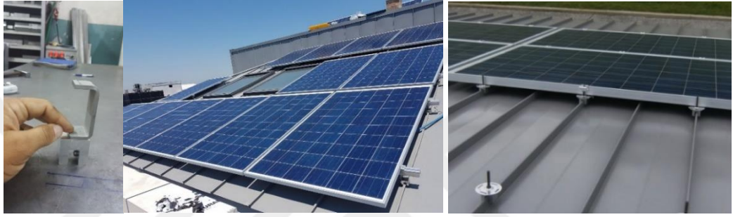
Şekil 6.6. Kenet çatı montaj parçası ve uygulamaları.(terasyapi.com.tr, 2020)
