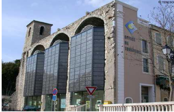
Şekil 6.31. Ales-Fransa turist ofisi cephe PV uygulaması. (Kanan, 2012)
