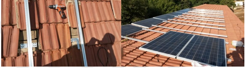
Şekil 6.2. Kiremit çatı montaj uygulaması.(Günder, 2018)
