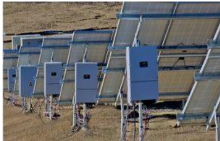
Şekil 5.15. Dizi invertörlerin tesiste bağlantı konumları. (enerjiportali.com, 2016)
