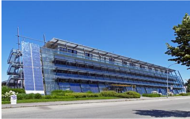
Şekil 6.32. Solar-Fabrik; Freiburg, Almanya. (solar-fabrik.de, 2020)
