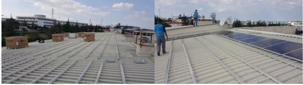
Şekil 6.4. Trapez çatı montaj uygulaması. (Günder, 2018)
