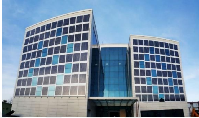
Şekil 6.27. Edirne Çevre ve Şehircilik İl Müdürlüğü binası cephe PV uygulaması. (ankarasolar.com.tr, 2020)
