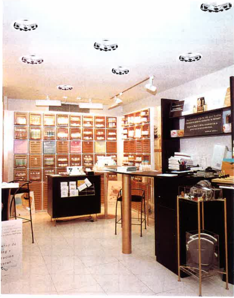
Şekil 4.1.3 Açık reflektörlü downlight uygulamalı bir teşhir mekanı
