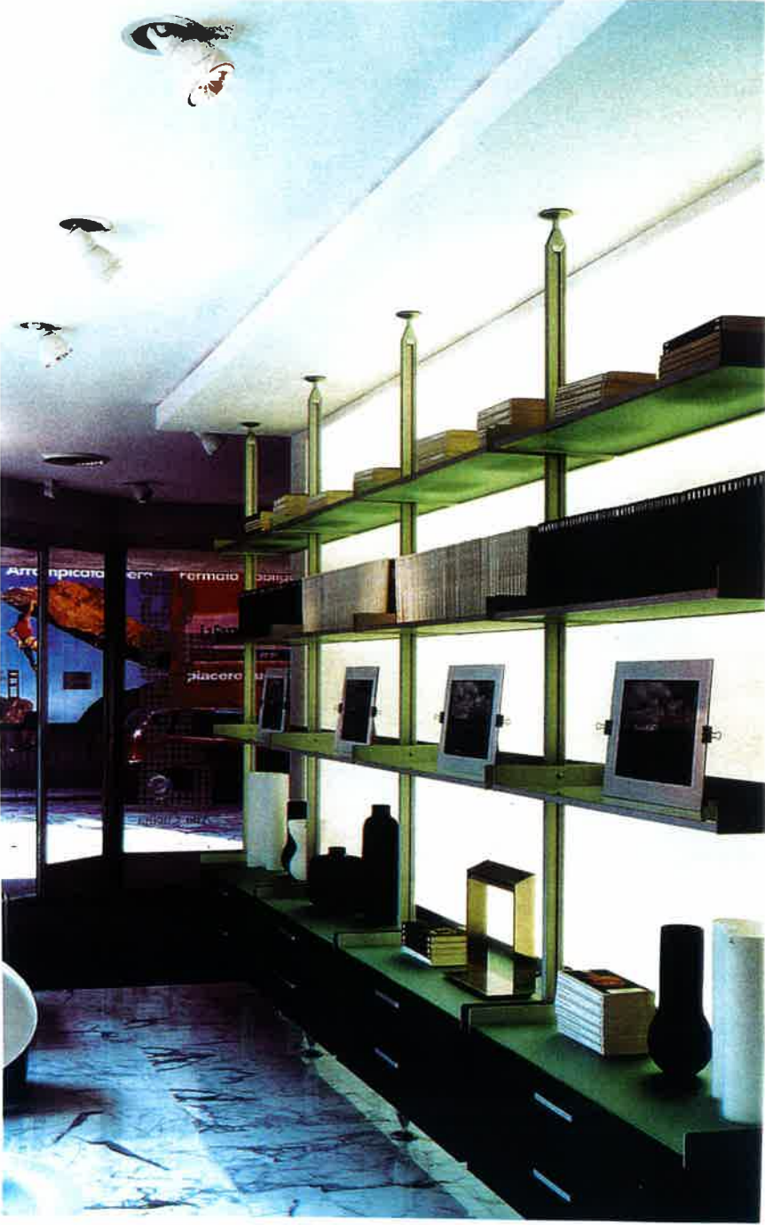
Şekil 4.1.9 Bir teşhir mekanında asmatavan altında raylı aydınlatma
