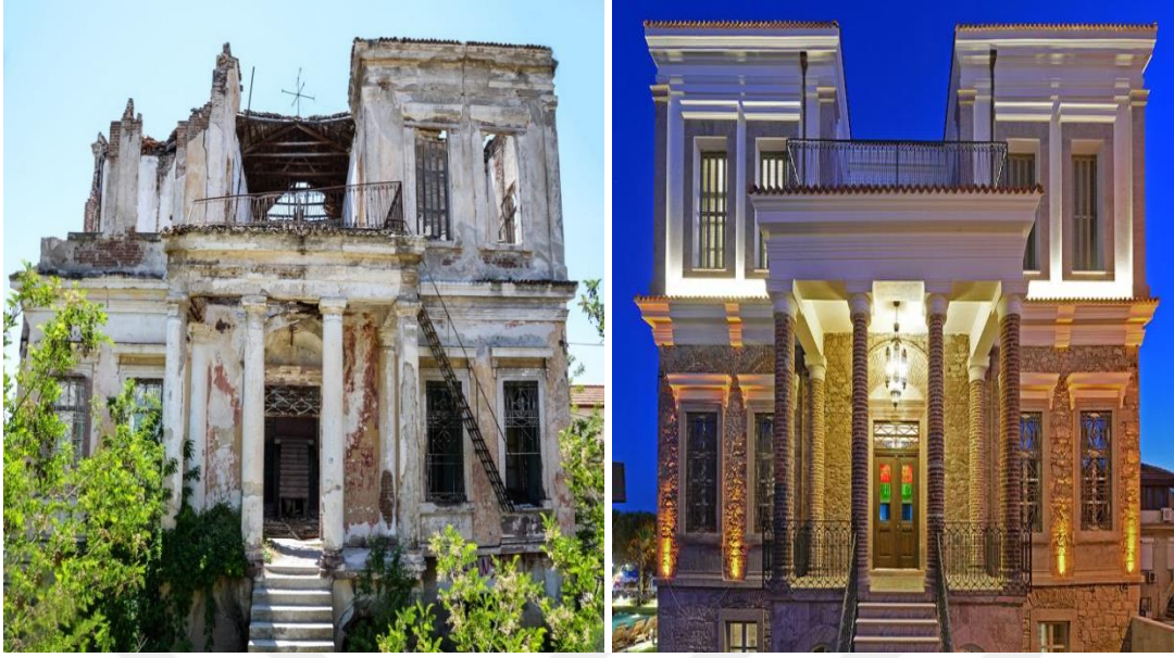
Şekil 15. Despot evi Restorasyon öncesi ve sonrası
