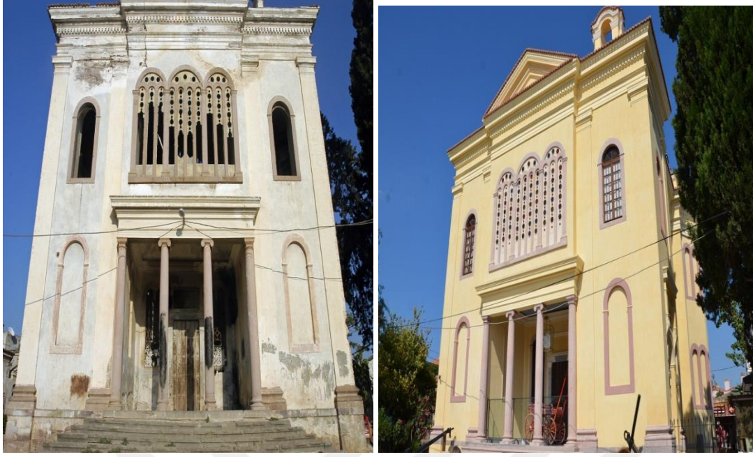
Şekil 7. Taksiyarhis Kilisesi dışı restorasyon öncesi ve sonrası
