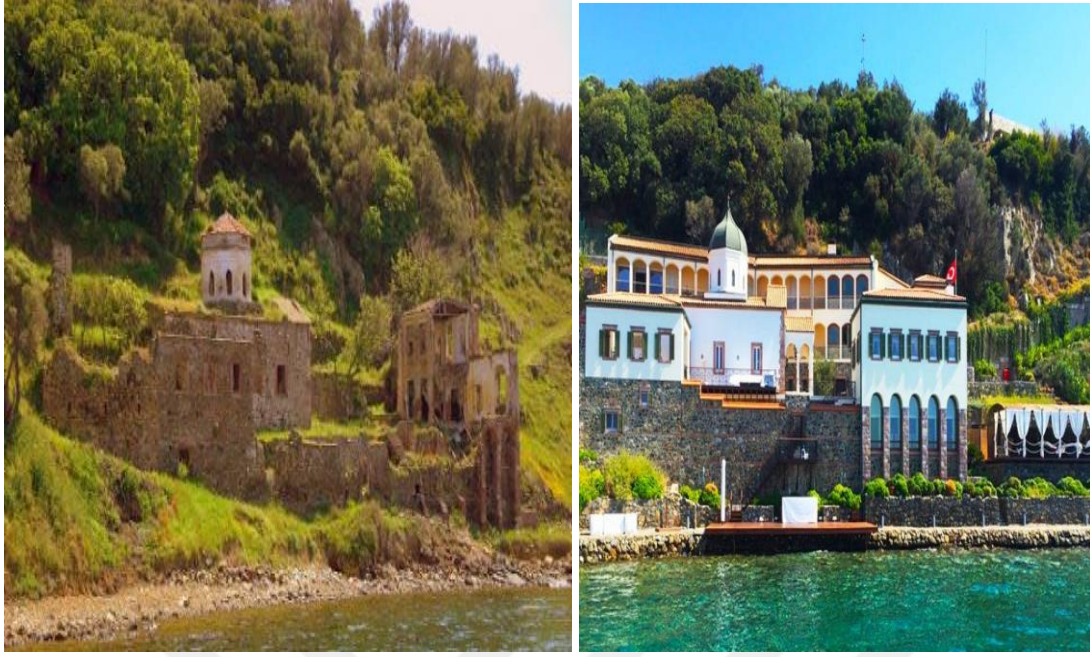
Şekil 12. Ayışığı Manastırı Restorasyon öncesi ve sonrası
