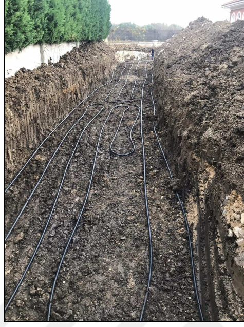
Şekil 3.3 : Yatay serme tipi toprak kaynaklı ısı pompasının uygulanaşı.
