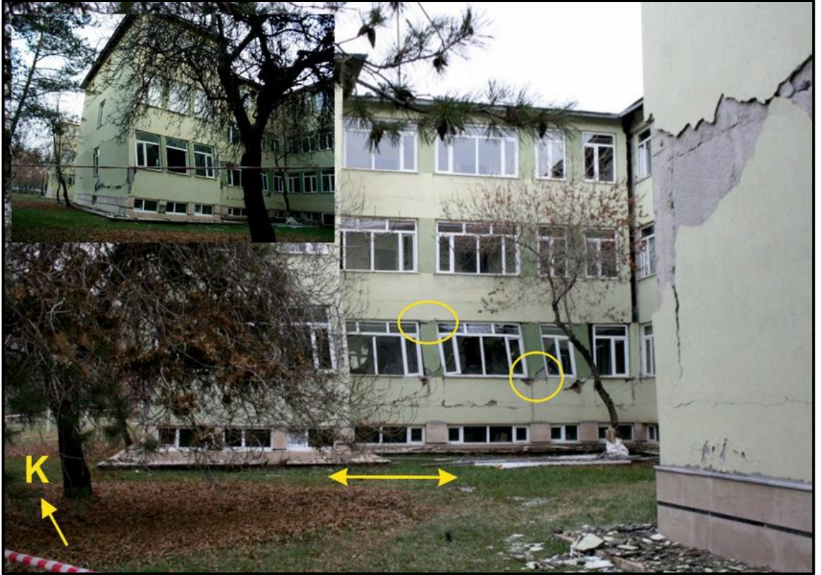
Şekil 4.178. DSİ binalarında D-B salınım sonucunda gerçekleşen mafsallaşma.
