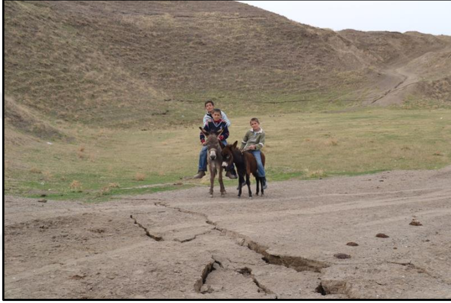
Şekil 4.172. Arısu Köyü civarında gözlenen yamaç diplerinde oturmaya bağlı gelişen kırılmalar.
