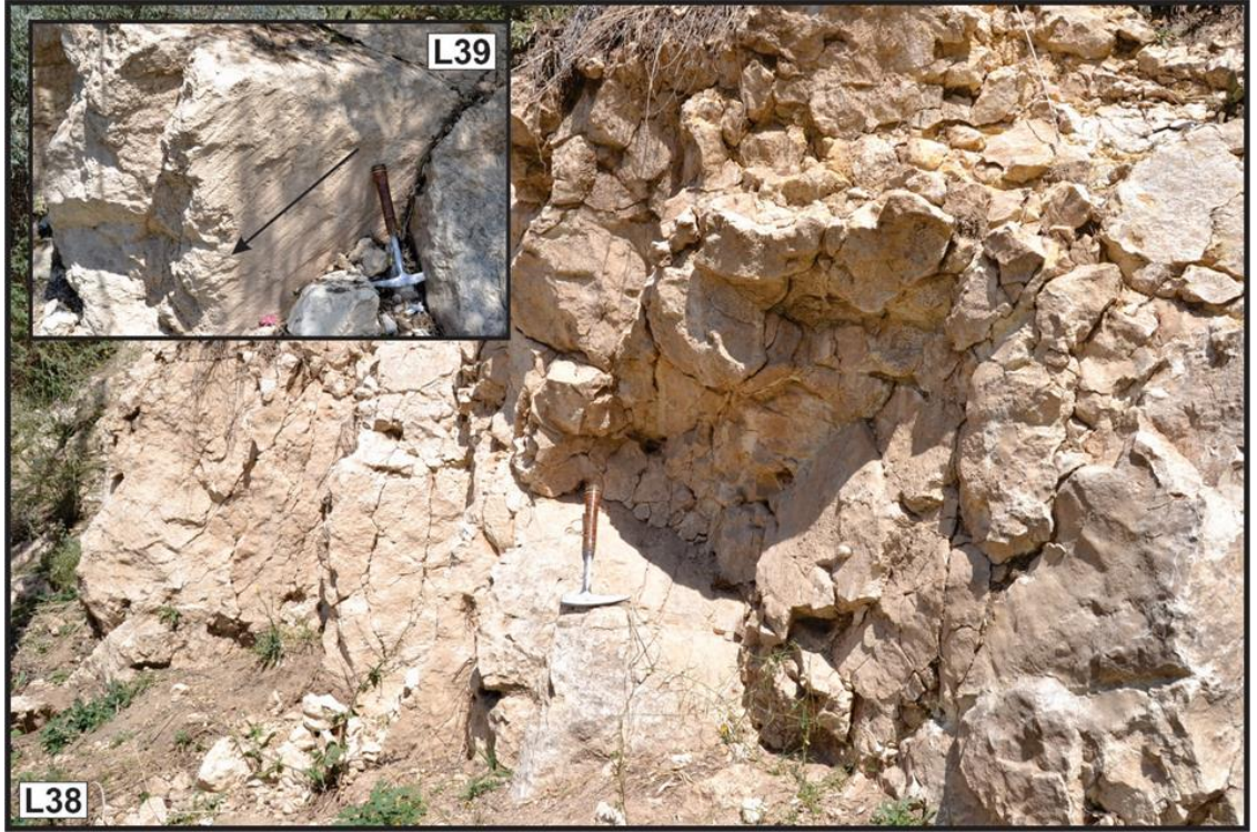
Şekil 4.105. L38 – L39 lokasyonlarda belirlenen fayın görünümü, fay çizgileri (küçük resim), bakış yönü GB.
