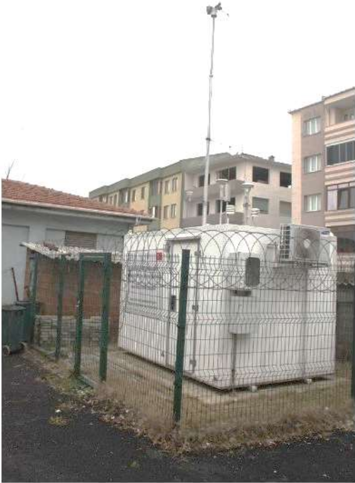
Şekil 31. Keşan Marmara Temiz Hava Merkezi (MTHM) İstasyonu dıştan görünüm
