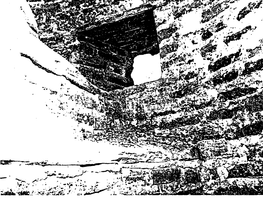
Resim 2.26.130. Malatya Ak Minare'nin basamak ve mazgal detayı
