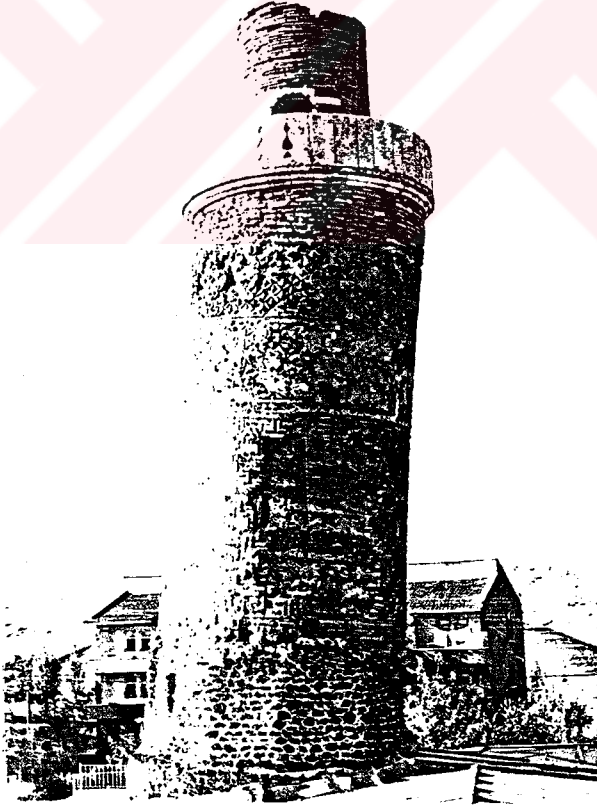
Resim 2.5.11. Harput Ulu Camii Minaresi
