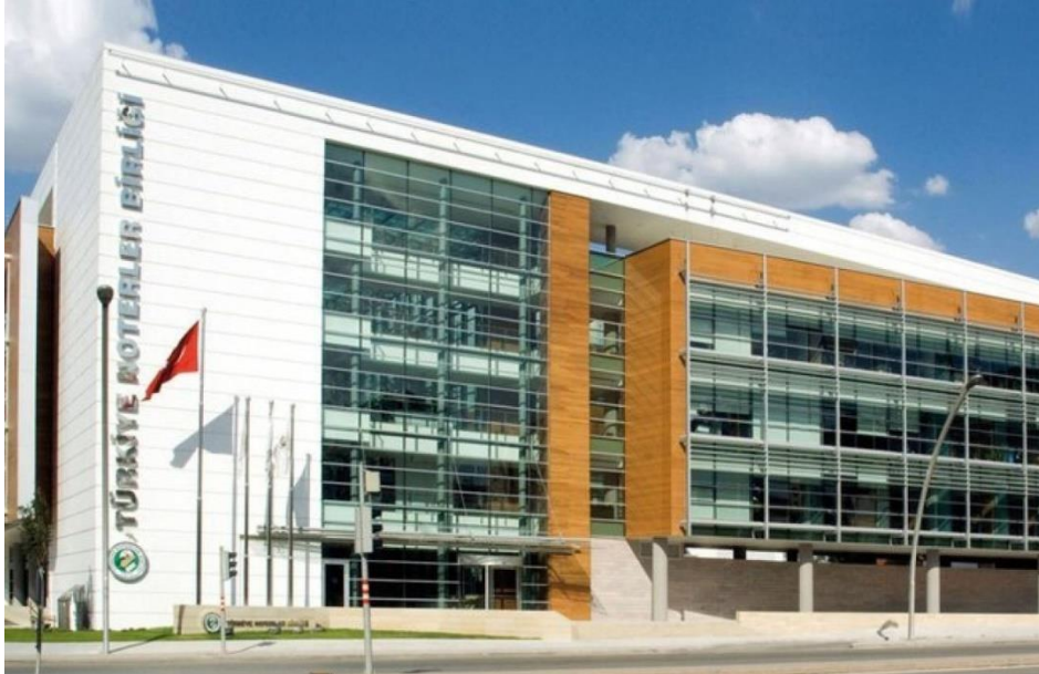
F.10: TNB Merkez Binası ve Kültürel Sosyal Tesisleri
