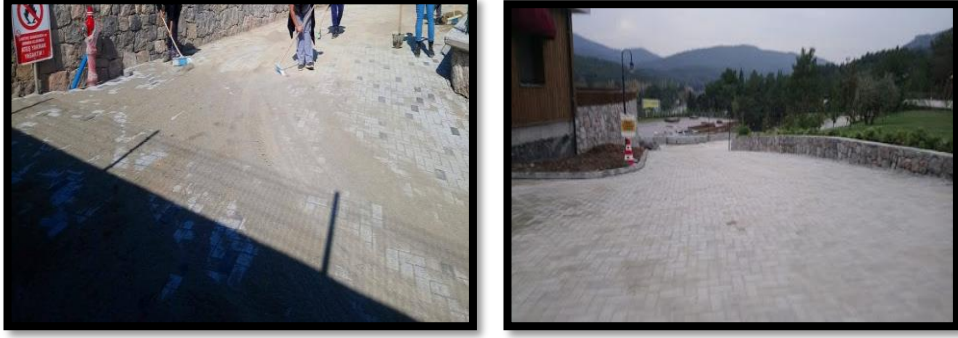
Şekil 4.34. Site içi Holland parke taşı döşeme sonrası kumlamayı süpürme işlemi
