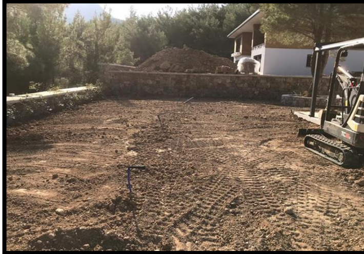
Şekil 4.25. 22 nolu konut bahçesi, sulama hattının kapatılması
