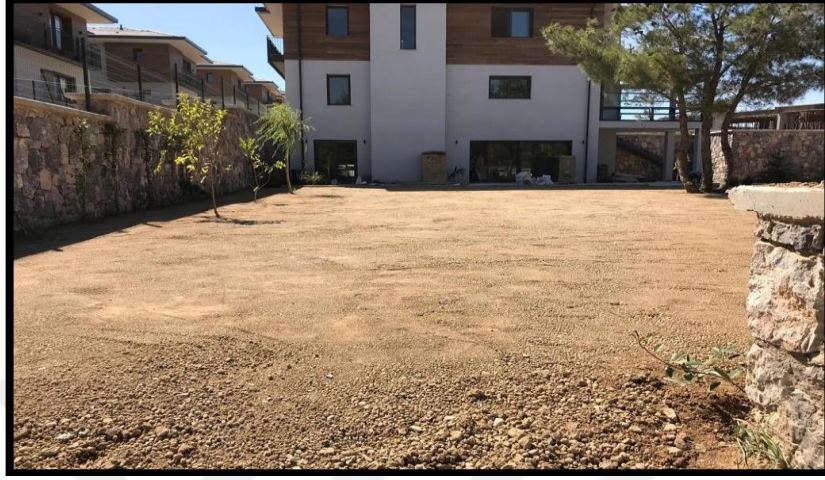
řekil 4.8. 14 nolu konut bahesi elenmiř bahe toprağı ince tesviye uygulama
