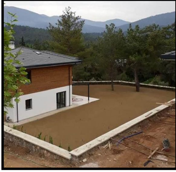
Şekil 4.10. 21 nolu konut bahçesi ince tesviye ve silindir uygulaması
