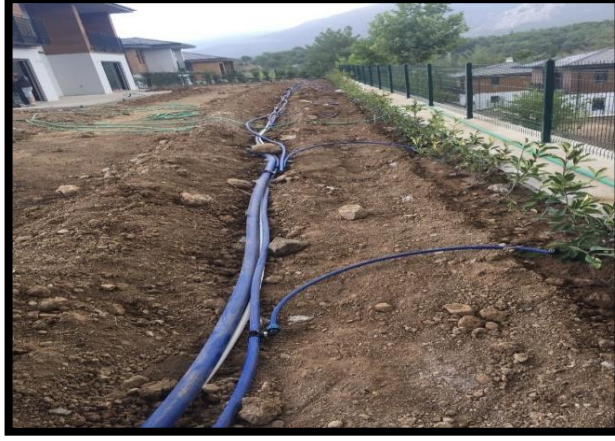
Şekil 4.21. 26 nolu konut bahçesi sulama hattı uygulaması
