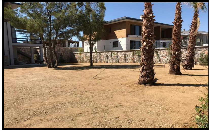
řekil 4.9. 14 nolu konut bahesi silindirleme dolgu toprağın sıkıřtırılması
