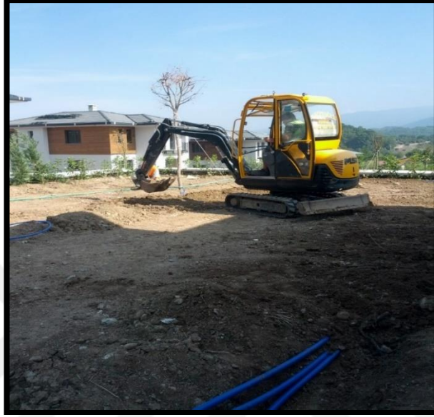
Şekil 4.24. 5 nolu konut bahçesi, sulama hattı kanallarının kapatılması
