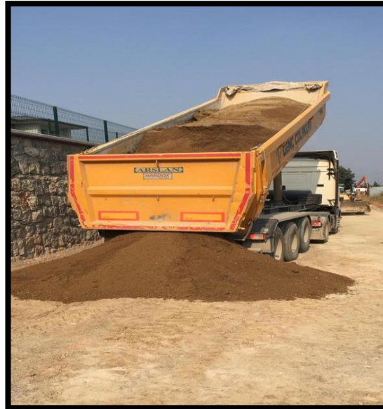
Şekil 4.7. Çim uygulaması için alanda kullanılan ince elenmiş bahçe toprağı
