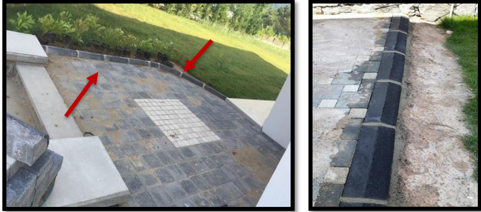
Şekil 4.36. 8 nolu konut bahçesi bina girişi bordür ve granül kaplamalı parke taşı uygulaması ve 3 nolu konut otopark bordür uygulaması
