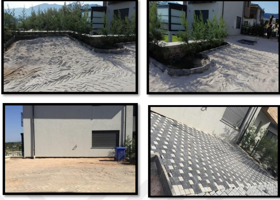
Şekil 4.32. 14 nolu konut bahçesi otoparkı granül kaplamalı parke taşı uygulaması Site içinde, özellikle eğimli yollarda su birikintisi yapmaması ve estetik bir görüntü sağlaması için (10cmx20cmx6cm) gri ve siyah Holland parke taşı kullanılmıştır (Şekil 4.33).
