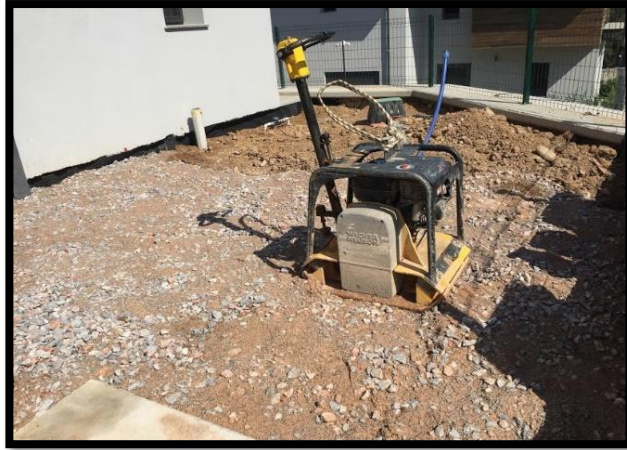
Şekil 4.31. 15 nolu konut girişinde kompaktör uygulaması
