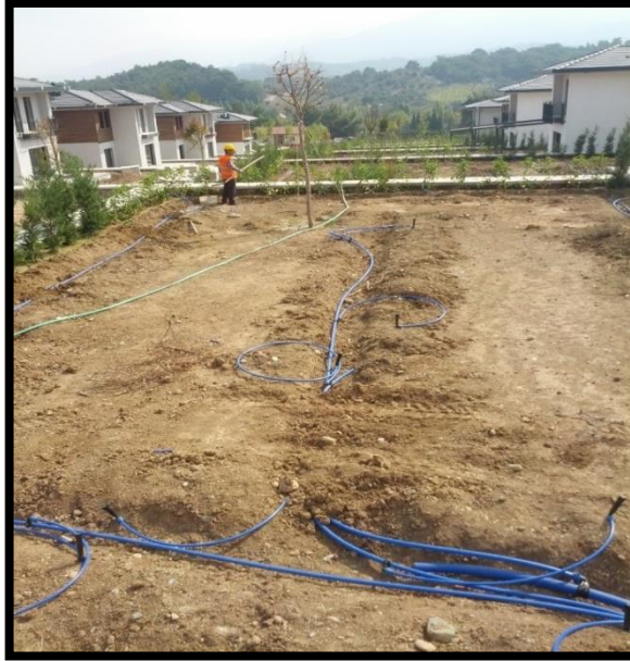
Şekil 4.23. 5 nolu konut bahçesi sulama hattı uygulaması
