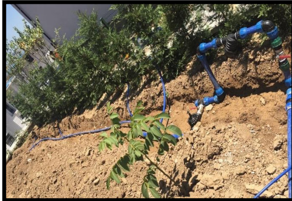
Şekil 4.20. 18 nolu konut bahçesi sulama hattı ana bağlantısı
