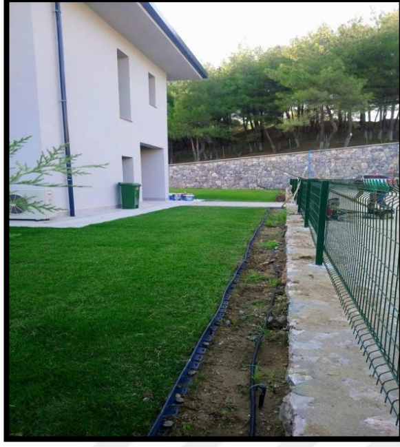
Şekil 4.26. 23 nolu konut bahçesi damlama sulama borusu uygulaması
