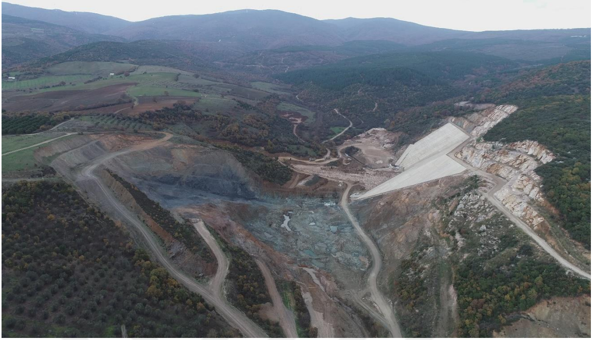
Şekil 3.4. Yeşildere Barajı memba görünüşü
