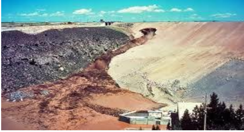
Şekil 2.11. ABD'deki Teton Barajı (Uysal, 1976)
