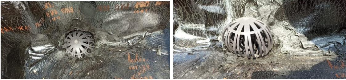
Şekil 3.13 .Çatı giderine yabancı maddelerin girmesini engellemek amacıyla örümcek adı verilen aparatın takılması
