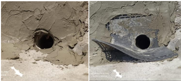
Şekil 3.9. Gider aparatının takılması
