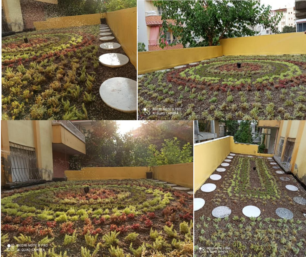
Şekil 3.20. Tercih edilen sedum tipi bitkilerin tasarlanan şekilde ekiminin yapılması
