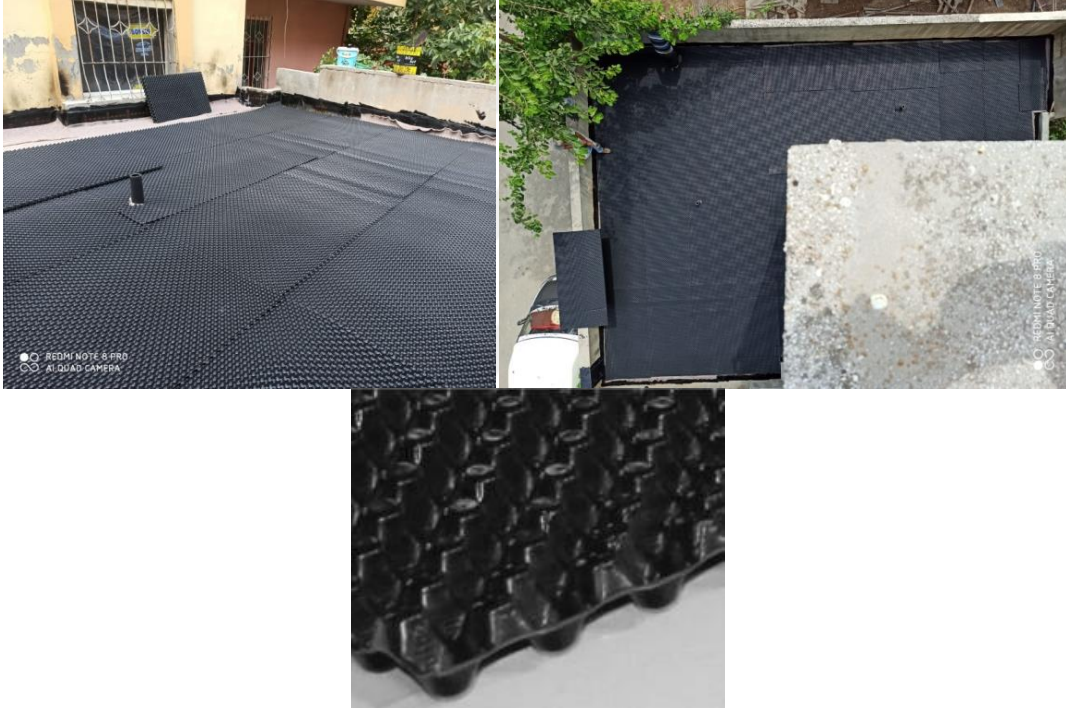
Şekil 3.16. Drenaj levhalarının yerleştirilmesi
