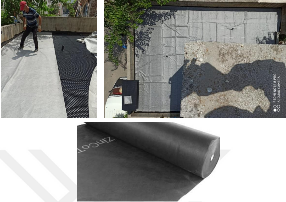
Şekil 3.17. Sistem filtresinin serilmesi
