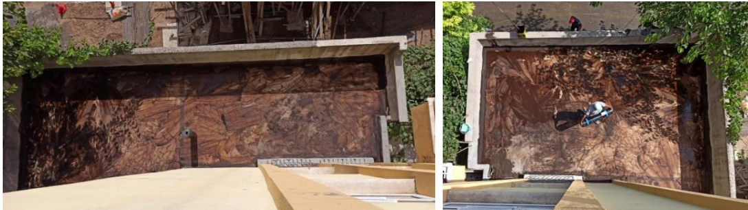
Şekil 3.11. Su yalıtımı için astarın uygulanması
