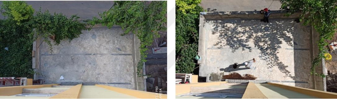
Şekil 3.8. Uygulama yapılacak olan çatıya sarkan ağaçların kaldırılması
