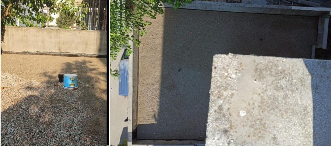
Şekil 3.18. Ponza taşı kiremit kırığı hayvansal gübre ve toprak karışımından oluşan bitki taşıyıcı tabakanın serilmesi
