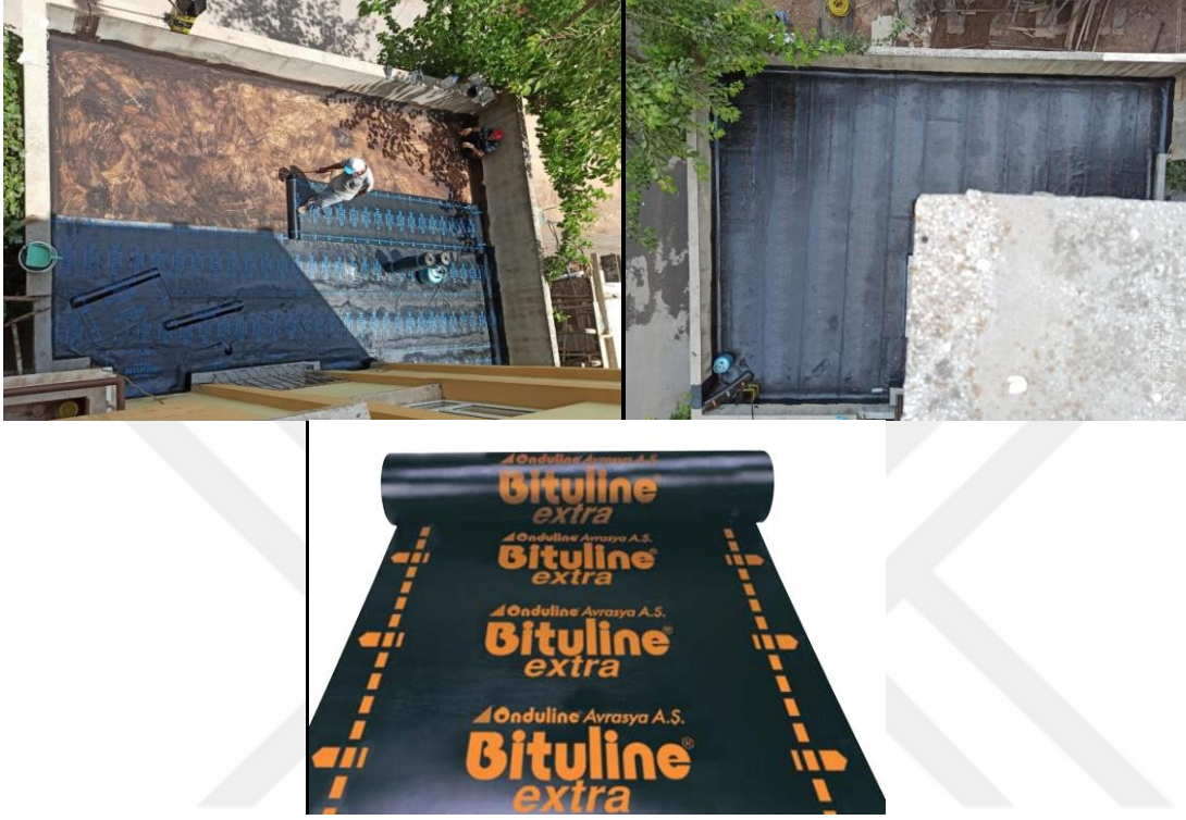
Şekil 3.12. Çift kat su yalıtımının uygulanması
