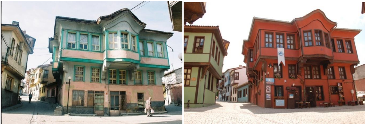
Foto 3.4. Iřıklar Sokak, Saėlıklařtırma ncesi ve Sonrası Durumu
