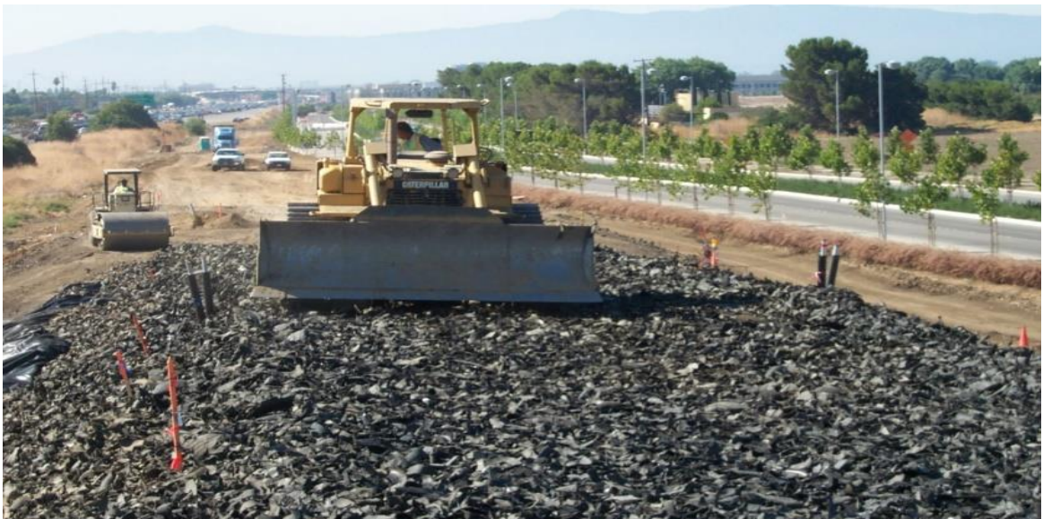
Şekil 2.4. Parçalanmış atık lastiklerinden toprak set oluşturma
