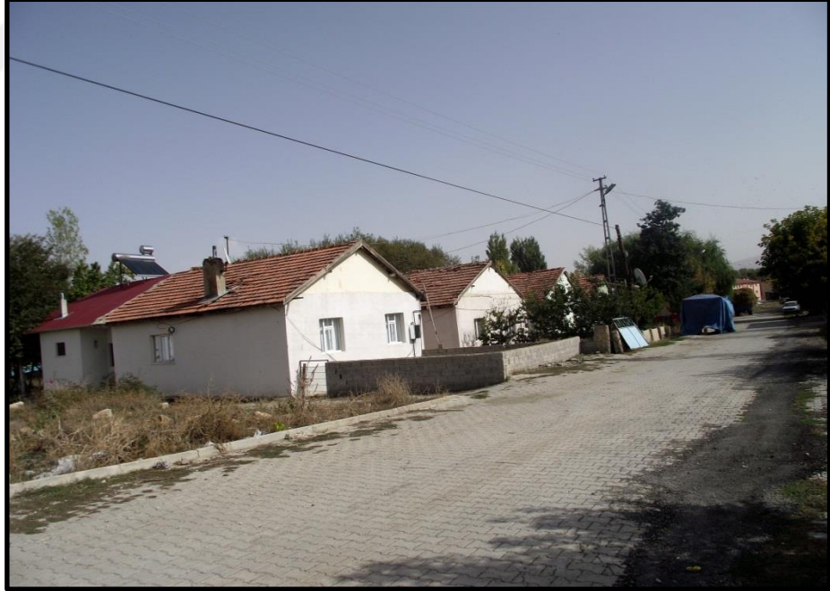
Fotoğraf 2.15. Çayırılı İlçe Merkezi'ndeki Eski Tip Deprem Konutları.
