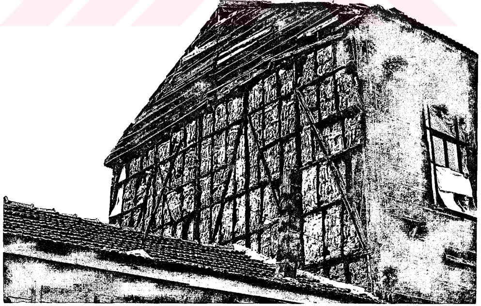
Resim 3.6: Ahşap iskelet sistemle inşa edilmiş ahşap kaplamalı bir konut.
