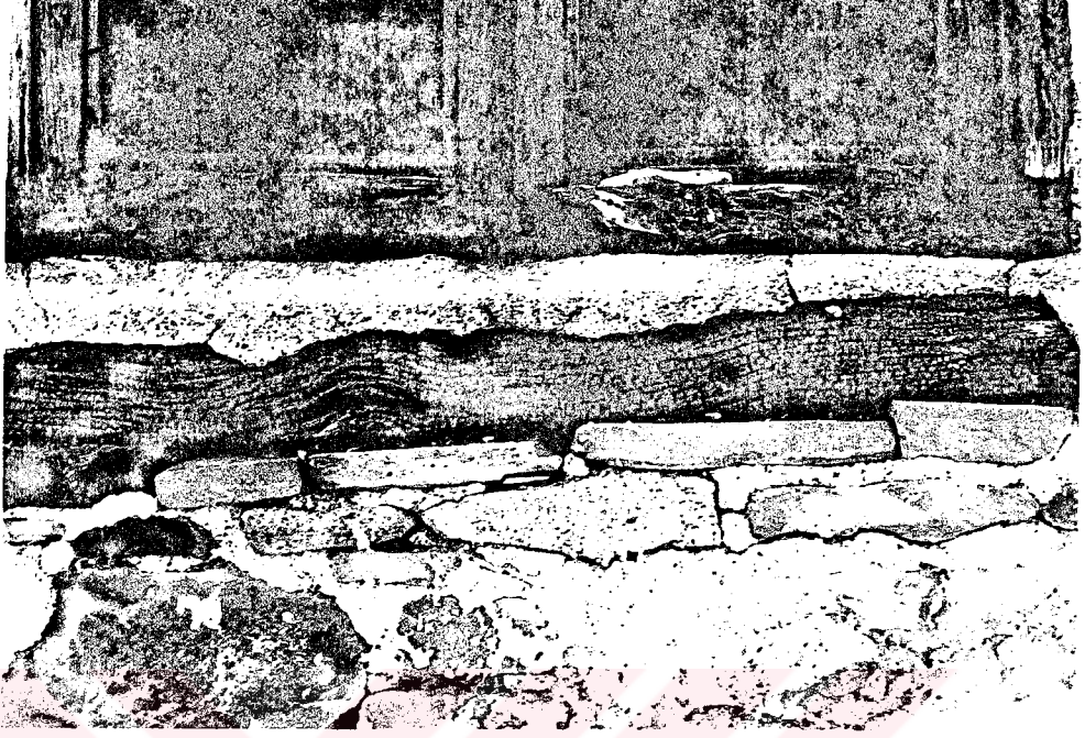
Resim 4.23: Ahşap malzemenin zamanla çürüyüp, tahrip olması.
