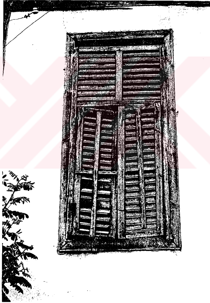
Resim 4.30: Ahşabın deformasyonu.
