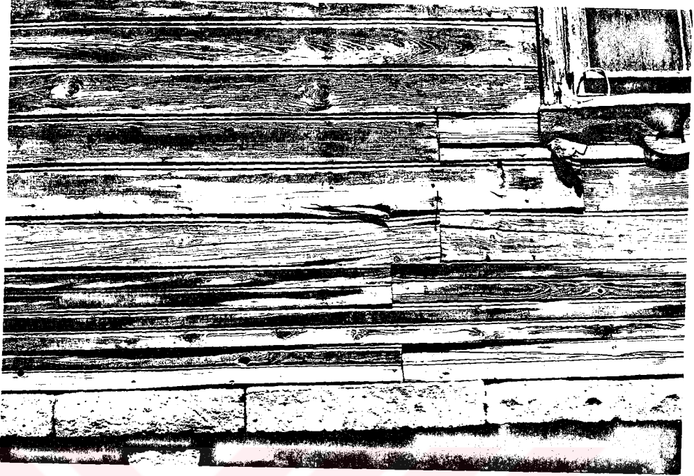
Resim 4.19: Ahşabın dış tesirlerle tahrip olması.
