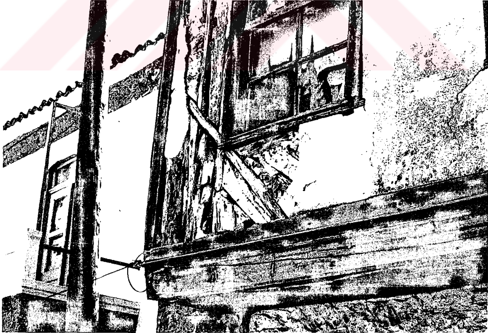
Resim 4.26: Ahşap malzemenin zamanla çürüyüp, tahrip olması.
