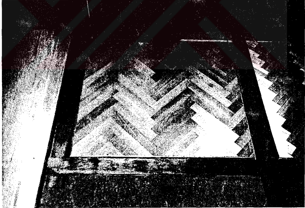
Resim 3.26: Balık Sırtı (Çapraz) Parke Döşeme Modeli.
