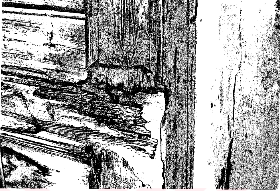
Resim 4.25: Ahşap malzemenin zamanla çürüyüp, tahrip olması.
