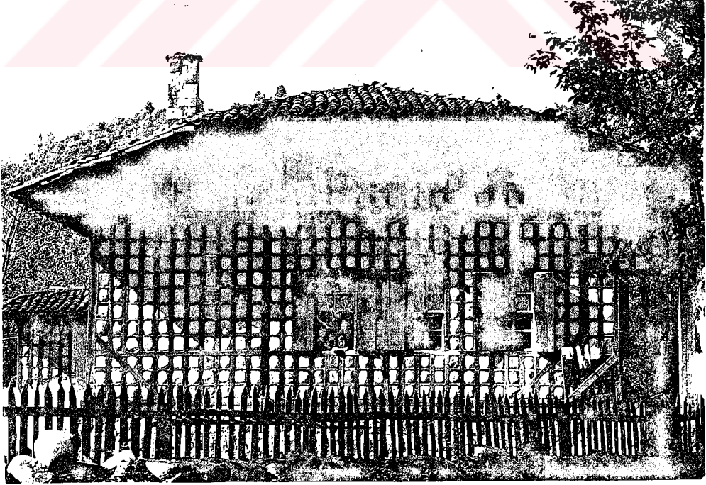
Resim 3.11: Dolgu malzemesi taş olan ahşap iskelet sistemli bir konut.
