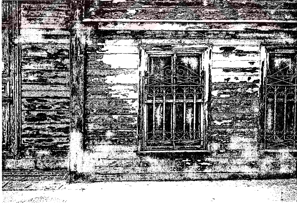
Resim 4.37: Gerekli bakımın yapılmadığı ahşap bir konutta oluşan tahribat.
