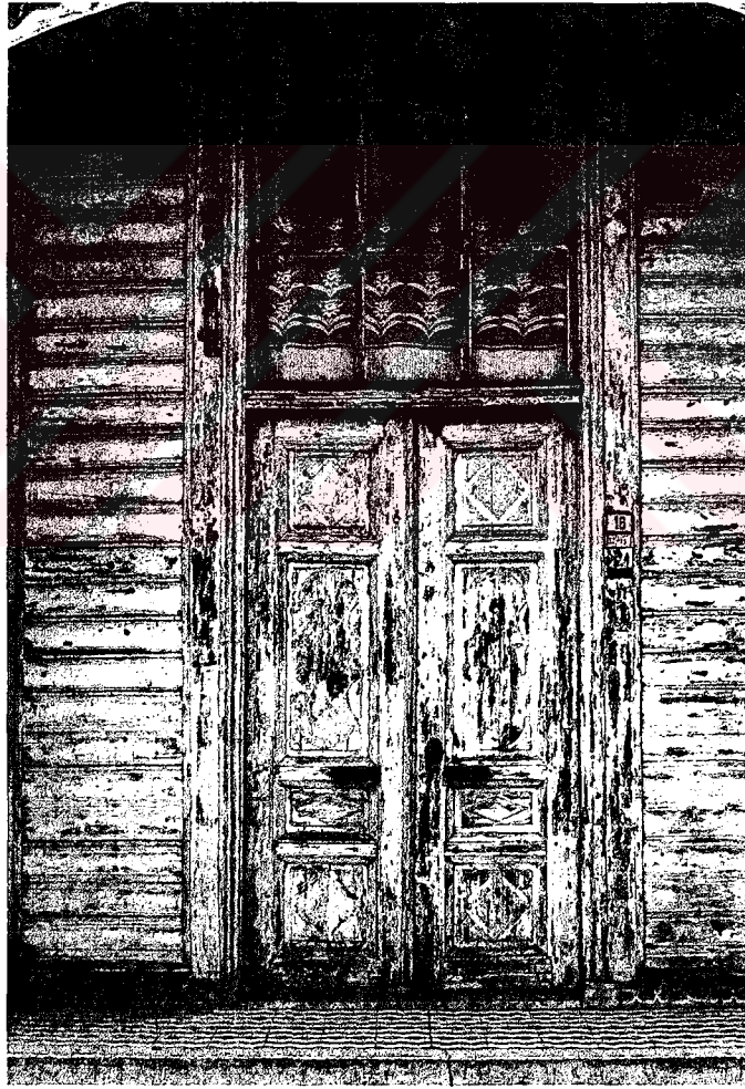
Resim 4.35: Gerekli bakımın yapılmadığı bir kapı doğramasında oluşan bozulmalar.
