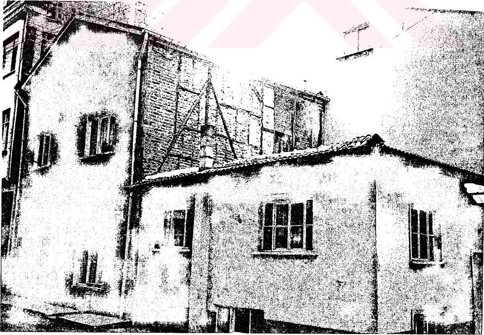
Resim 3.9: Dolgu malzemesinde tuğla kullanılan ahşap iskeletli bir konut.
