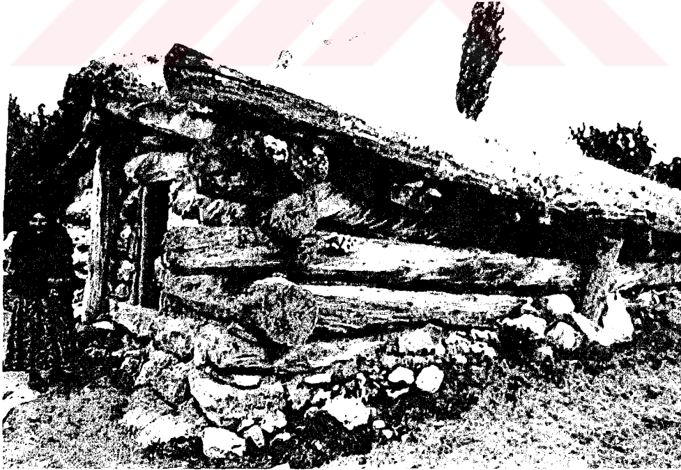
Resim 3.1: İşlenmemiş ahşap elemanlarla yapılan yığma sistemli bir konut.
