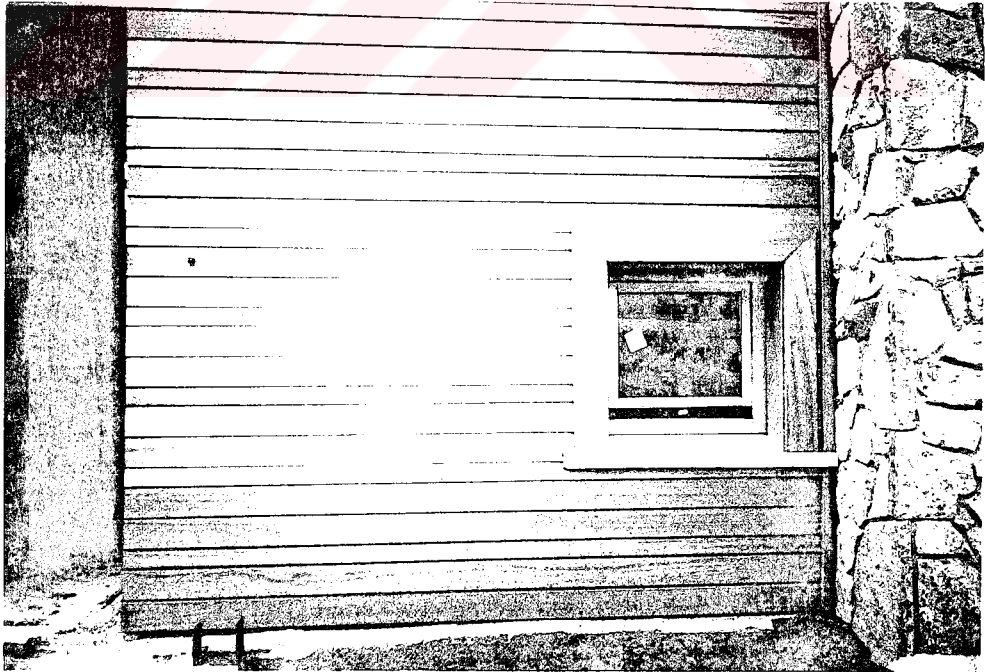
Resim 3.52: Pencere doğramalarında ahşap kullanılan bir konut.
