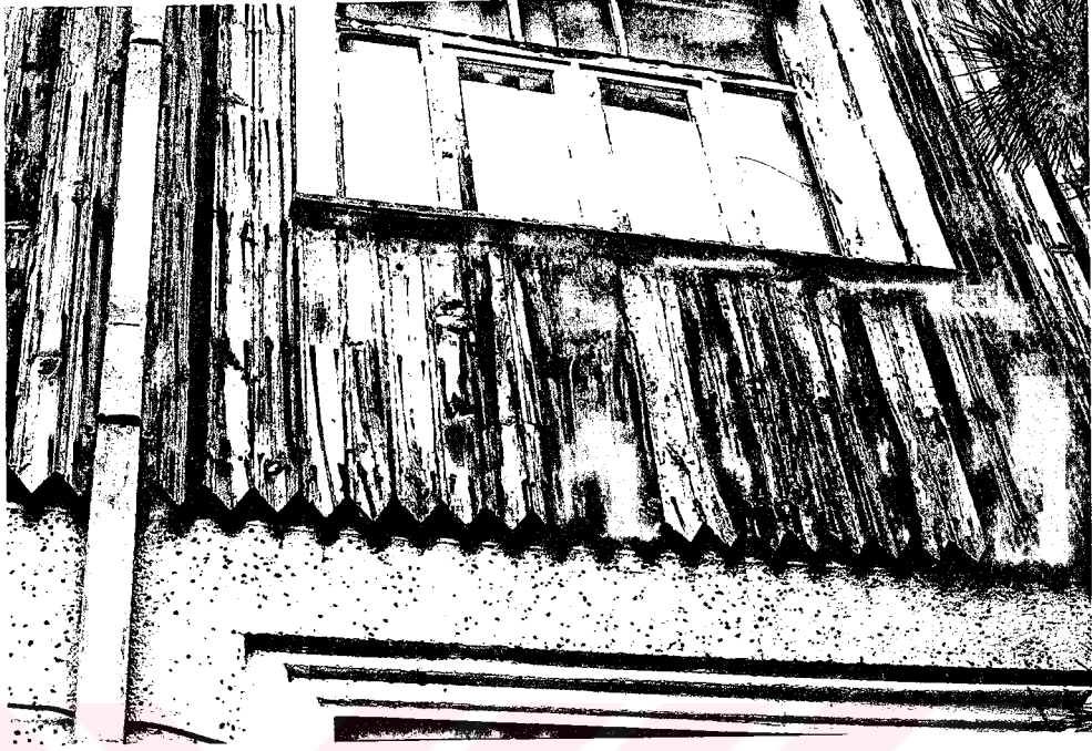
Resim 4.17: Ahşabın dış tesirlerle tahrip olması.
