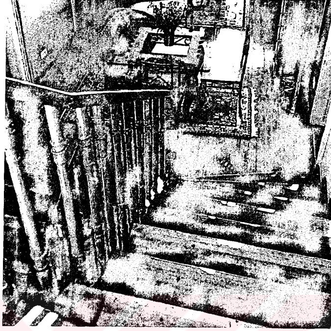
Resim 3.41: Ahşap korkuluk elemanları kullanılan bir merdiven.
