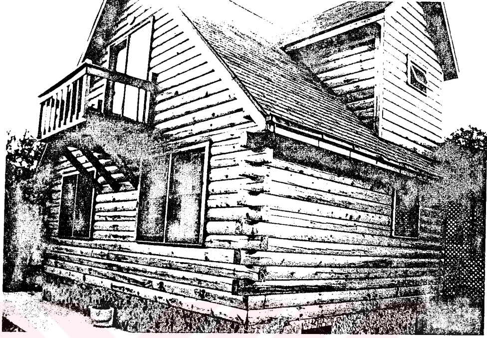
Resim 3.2: İşlenmiş ahşap elemanlarla yapılan ahşap yığma sistemli bir konut.
