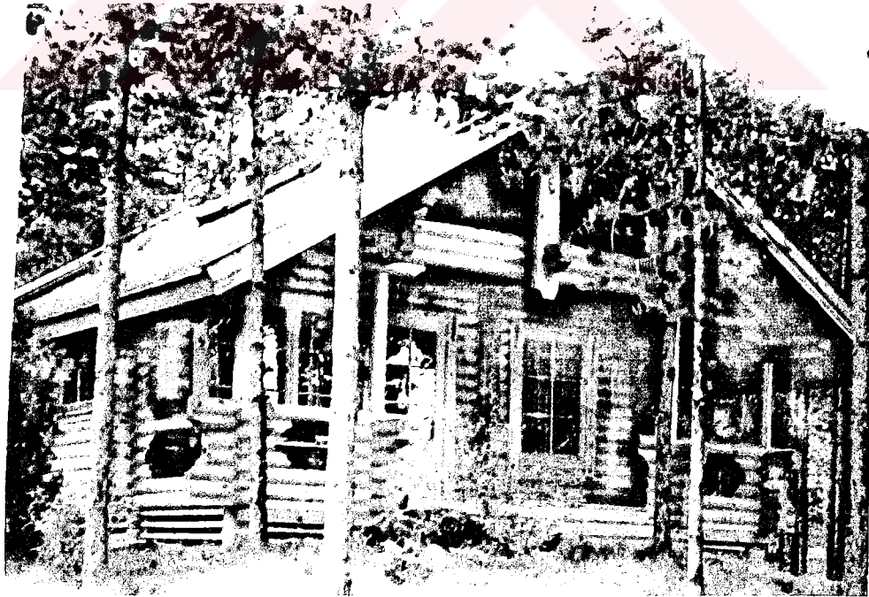
Resim 3.4: Ahşap yığma sistemle yapılmış olan bir kütük ev.
