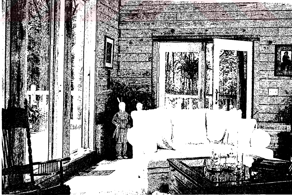
Resim 3.20: Oturma mekanı iç duvarları lambriyer döşenmiş bir konut.
