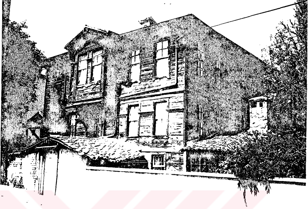
Resim 3.5: Ahşap iskelet sistemle inşa edilmiş ahşap kaplamalı bir konut.
