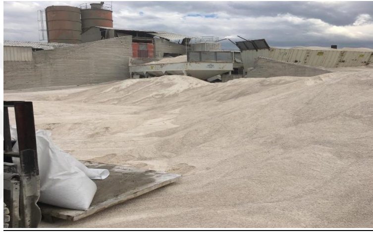
Şekil 2.5. Erbaa Beton Parke Üretim Tesisi
