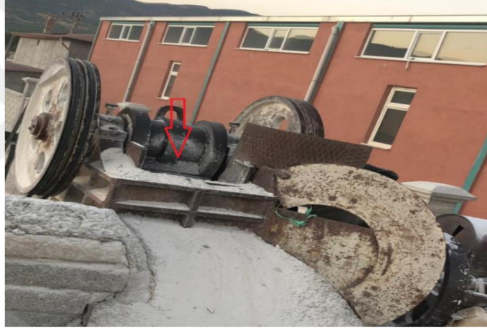
Şekil 2.3. Beton Atıklarının Konkasörde Kırılması
