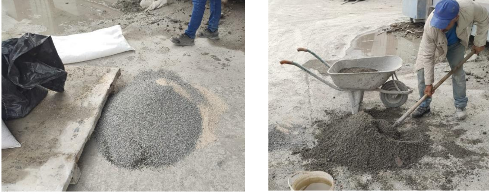
Şekil 2.7. Prefabrik Beton Kaplama Elemanı Betonu Hazırlanması
