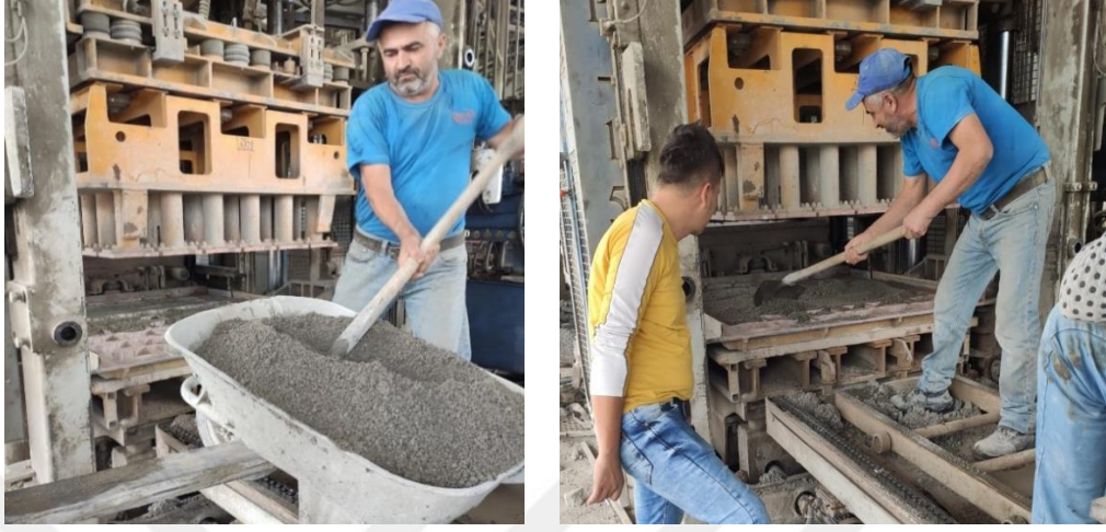
Şekil 2.9. Beton Parke Makinasına Elle Betonun Yerleştirilmesi
