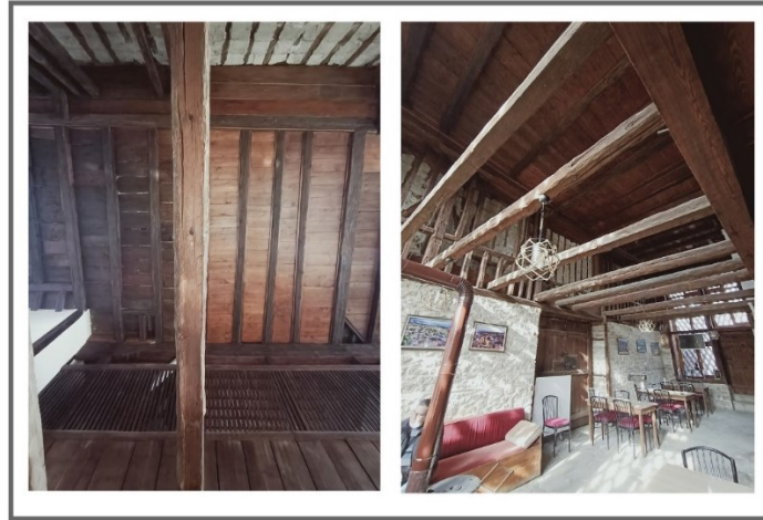
Şekil 4.18 Keçeci Mehmet Ulucan Şehir Evi hayat kısmında yer alan ahşap taşıyıcılar (Ünal,2021).
