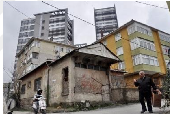
Figure 9: La transformation urbaine à Fikirtepe, février 2018, accès par https://kadikoygazetesi.com/61177-isinin-ehli-olan-fikirtepede-yukseldi
