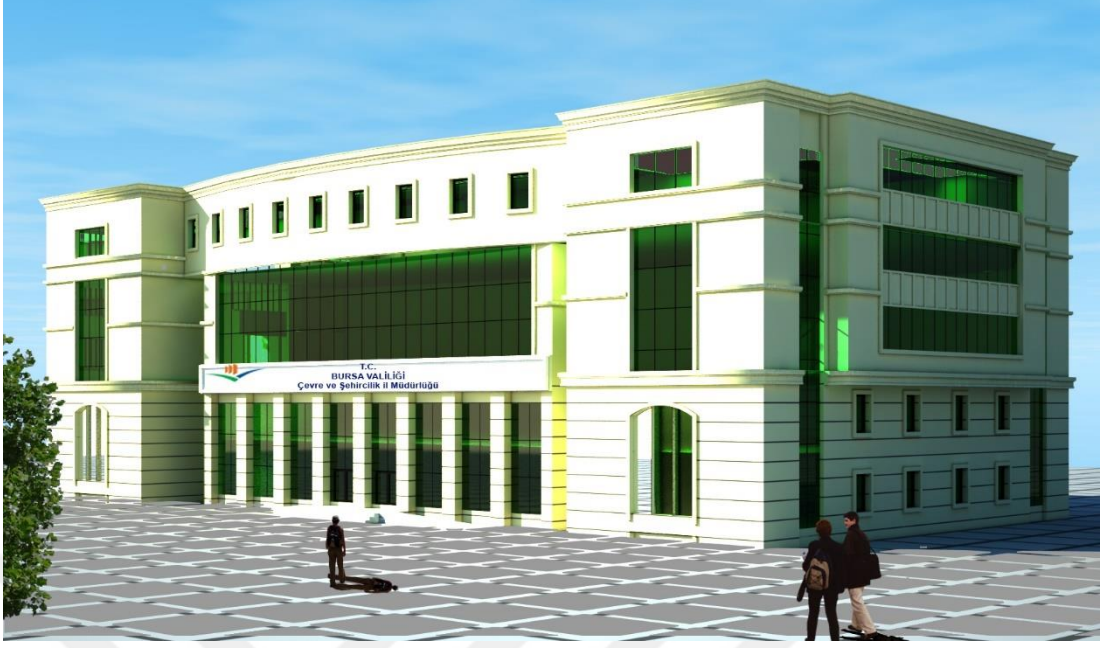
Şekil A.1 : Denek bina güneybatı cephe görünüşü.
