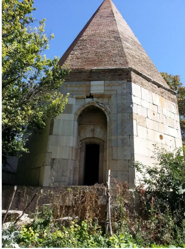
Fotoğraf 1: Şeyh Bedreddin Türbesi (Ilgın)
