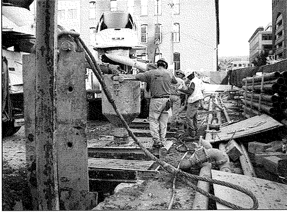
Şekil 3.10. Kazı çukuruna tremi ile beton dökülmesi
