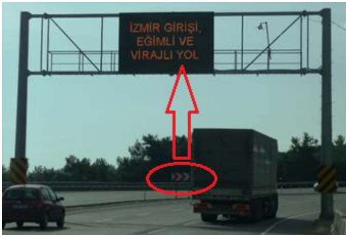
Resim 4.2. DMİ’de statik durumun (eğimli ve virajlı yol) verildiği mesaj
