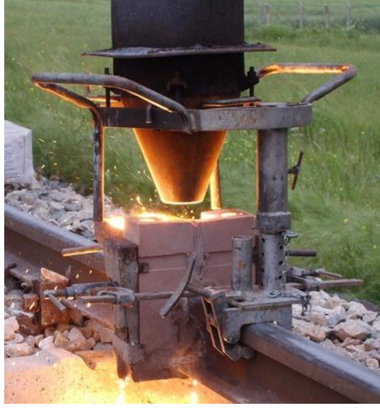
Şekil 1.9. Raylarda termit kaynak uygulaması [17].
