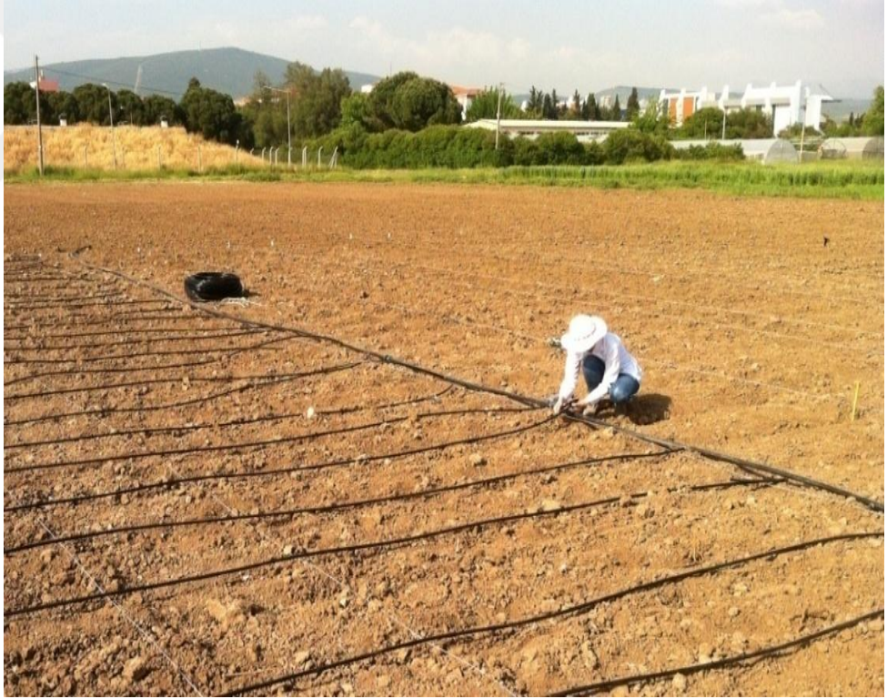
Şekil3.4 Damla Sulama Sisteminin Kurulması
