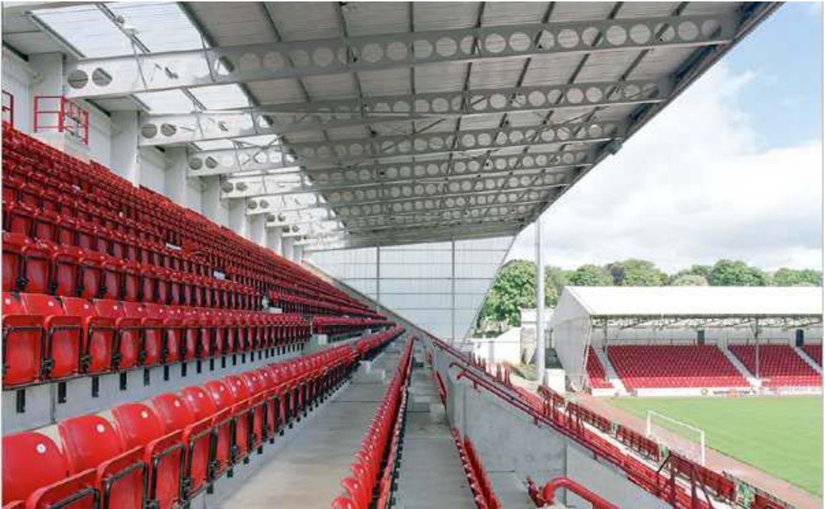
Şekil 1.10 Bir stadyumda petek kirişlerin konsol dizaynı, Dumferline
