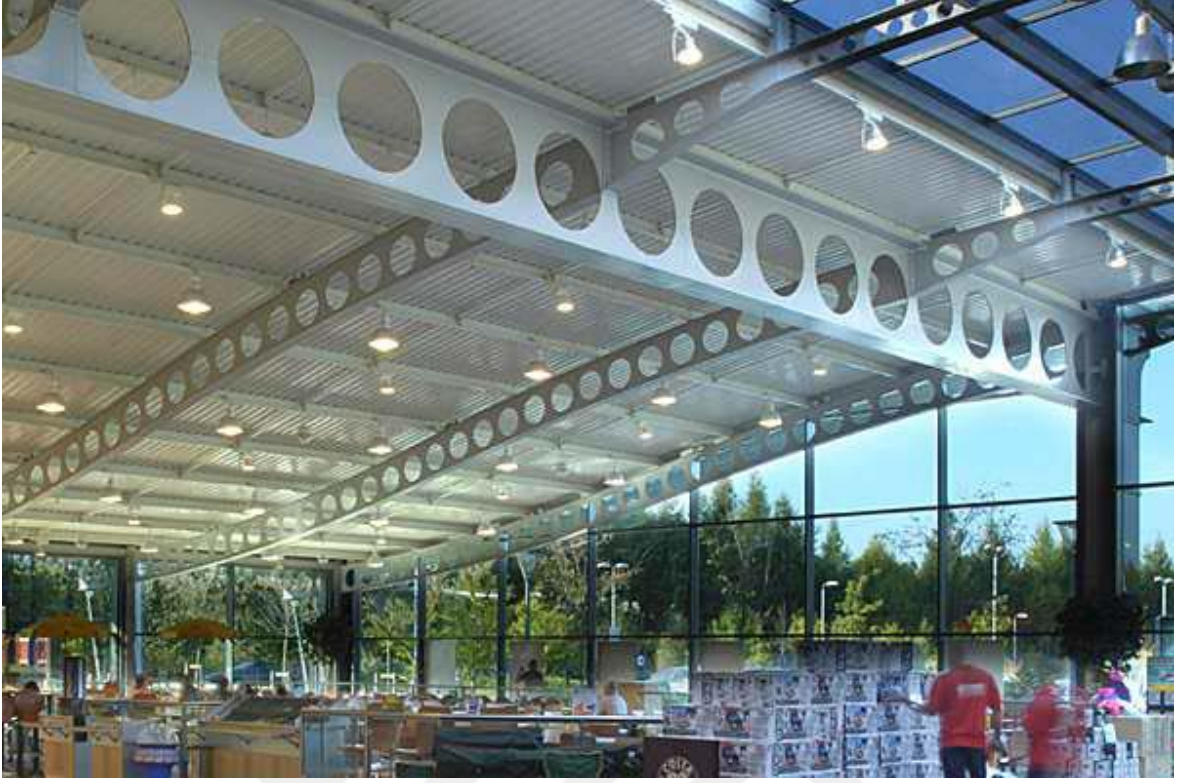
Şekil 1.7 Bir eğrisel petek kiriş uygulaması, Winchester
