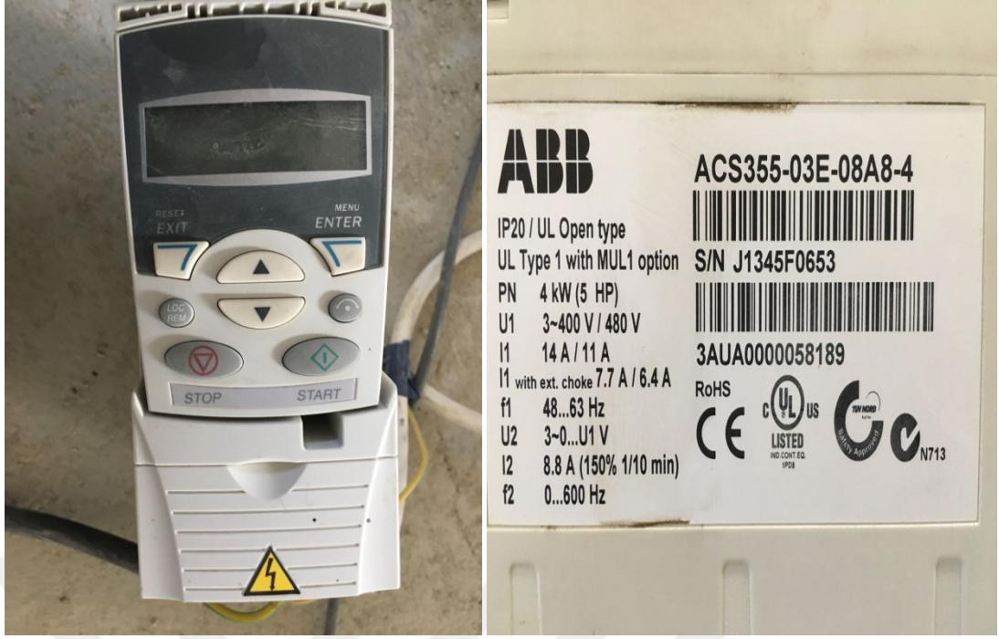
Şekil 3.7. Hız konvertörü ve tanıtım etiketi
