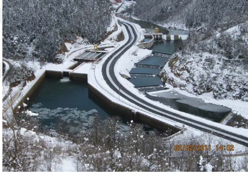
Şekil 4.33. Regülatör yapısının bitmiş hali
