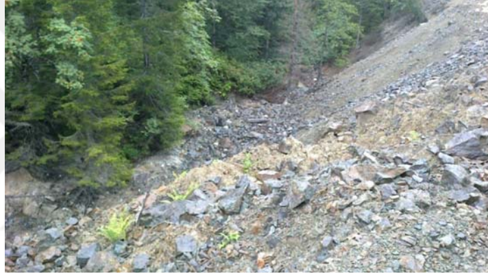
Şekil 4.40. Gelevera Vadisi'nde HES için yapılan yol inşaatından çıkan hafriyatın tamamen dereye verilmesi ve derenin kapatılması
