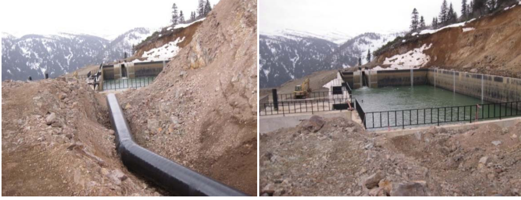
Şekil 4.36. Yükleme havuzunun yapılmış hali
