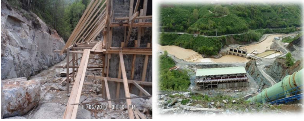
Şekil 4.38. Santral binası inşaatı (Çiğdem HES ve Akköy Espiye HES)
