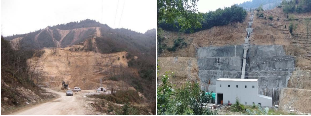
Şekil 4.37. Cebri boru yapımı için yapılan kazı ve cebri boru imalatı
