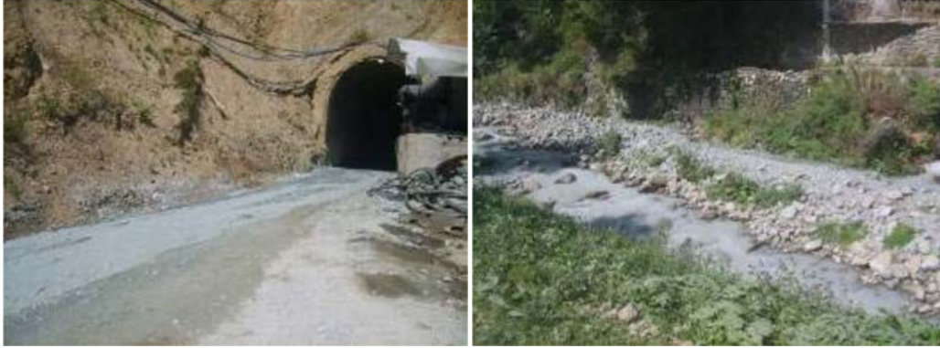
Şekil 4.34. Tünelden çıkan bulanık suyun dinlendirilmeden dere yatağına bırakılması
