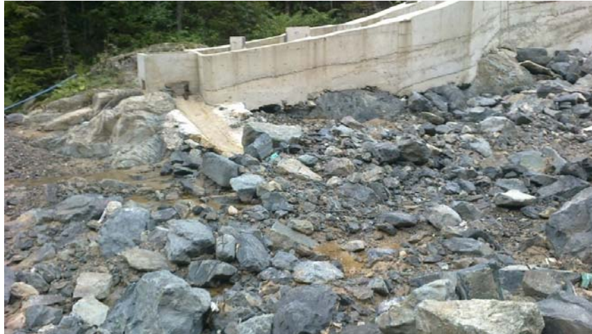
Şekil 4.44. Giresun Gelevera deresinde kurulan HES in balık geçidi
