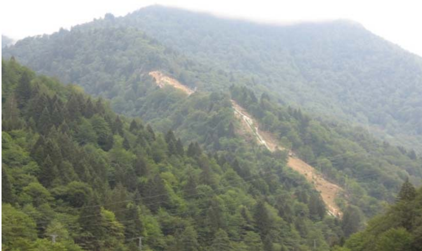
Şekil 4.54. Cevher HES cebri boru inşaat aşaması (yaz ayında çekilmiş fotoğraf)
