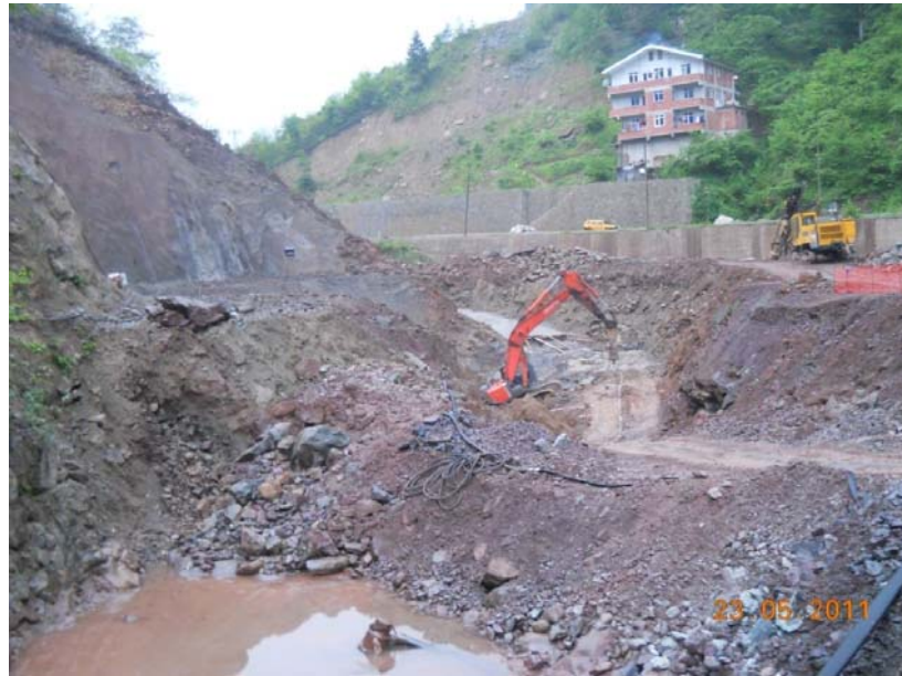
Şekil 4.43. HES inşaatı sırasında dere yataklarında yapılan çalışma
