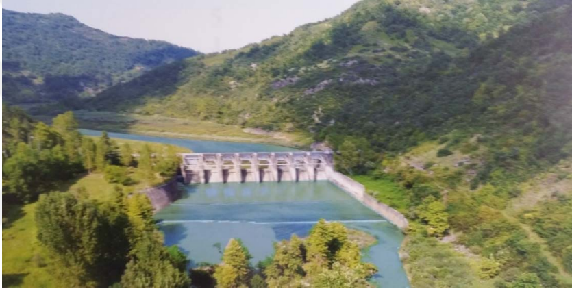
Şekil 4.53. Güllüç Barajı Ereğli/Zonguldak
