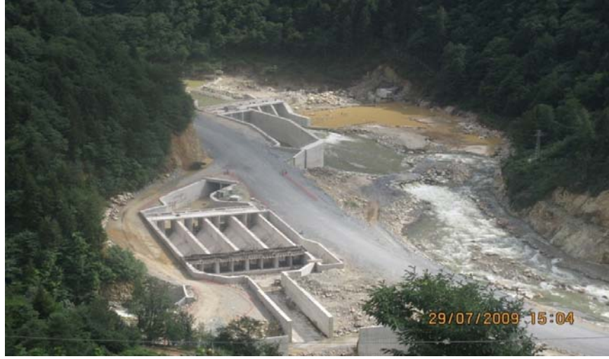
Şekil 4.32. Su alma yapısı (Regülatör) yapım aşaması
