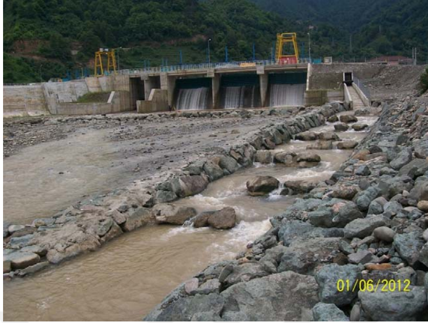
Şekil 4.45. Trabzon Solaklı Vadisi'nde kurulan Arca HES' e ait balık geçidi
