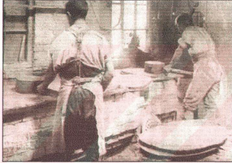
Resim 27 : 1932 Yılında Acme Marls Tarafından Kurulan J W A Lovatt Firmasında, 1900'lerde Bir Sagar Kutusu Şekillendirme Çalışması.
