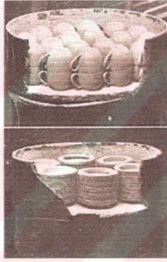
Resim 30 : Wedgwood Tarafından Üretilen Sagar Kutularının İçerisinde, Seramik Ürünlerin Pişirimi. http://www.netcentral.co.uk/steveb/postcards/wedgwood/8.html
