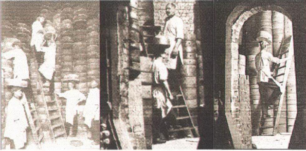
Resim 31 : Sagar Kutularının Fırın İçerisine Yerleştirilmesi. http://www.netcentral.co.uk/steveb/bottle_kiln/saggar.html http://www.netcentral.co.uk/steveb/postcards/wedgwood/8.html
