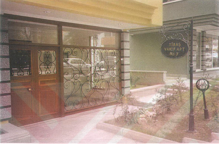
EK 12: Bahçelievler 2. Terti İnşaatlarının Dış Cephe Görüntüleri
