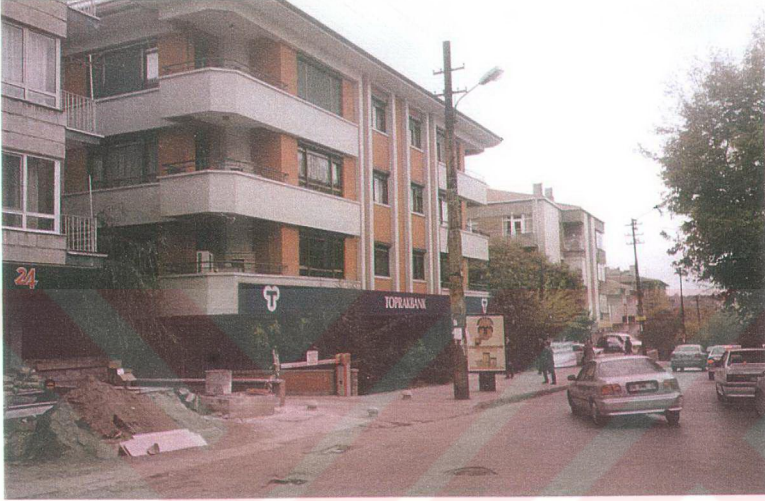
EK 1: Bahçelievler 1 Apartmanı Cephe Görüntüleri
