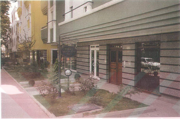
EK 10: Bahçelievler 2. Tertip İnşaatlarının Dış Cephe Görüntüleri
