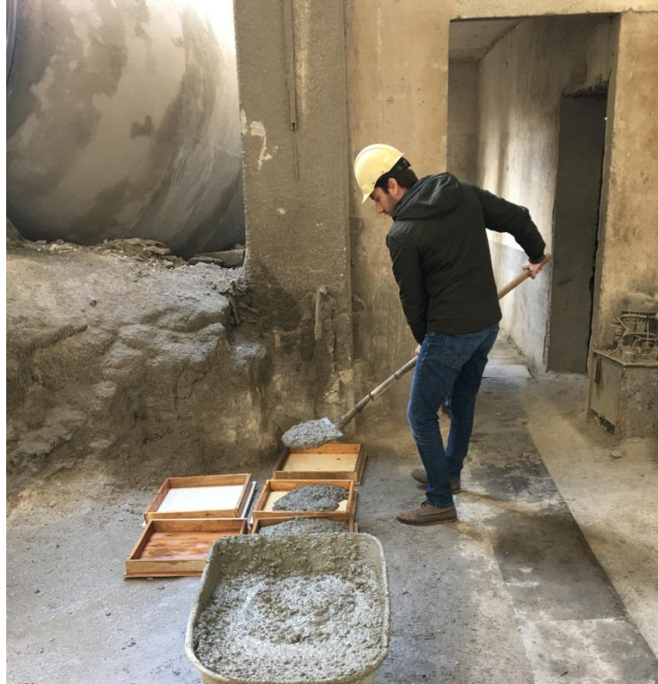
Şekil 6.4. Hazırlanan kalıplara beton dökülmesi
