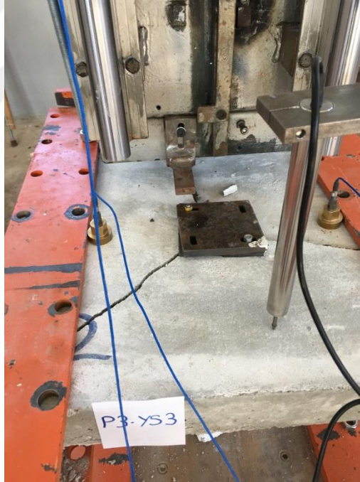
Şekil 7.24. P3-YS3 deney elemanında meydana gelen göçme hasar
