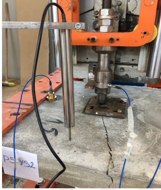
Şekil 7.43. P5-YS2 deney elemanında meydana gelen çatlaklar
