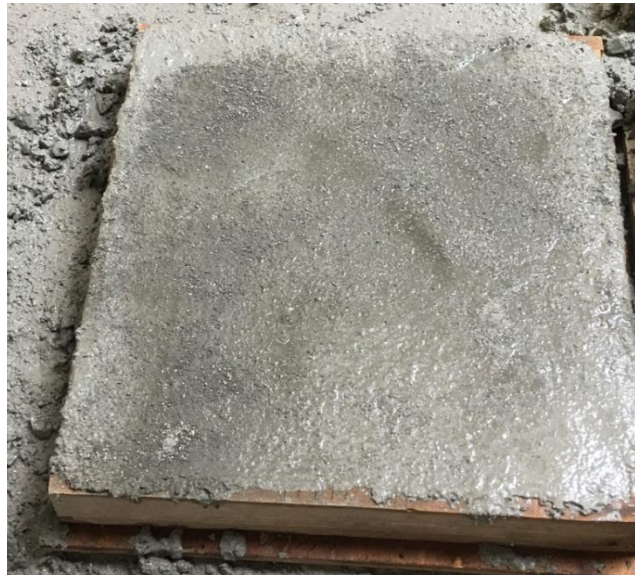
Şekil 6.5. Yüzey sertleştiricinin taze betona serpilmiş hâli
