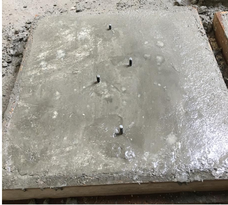
Şekil 6.6. Yüzey sertleştirici uygulanmış betonun son hâli
