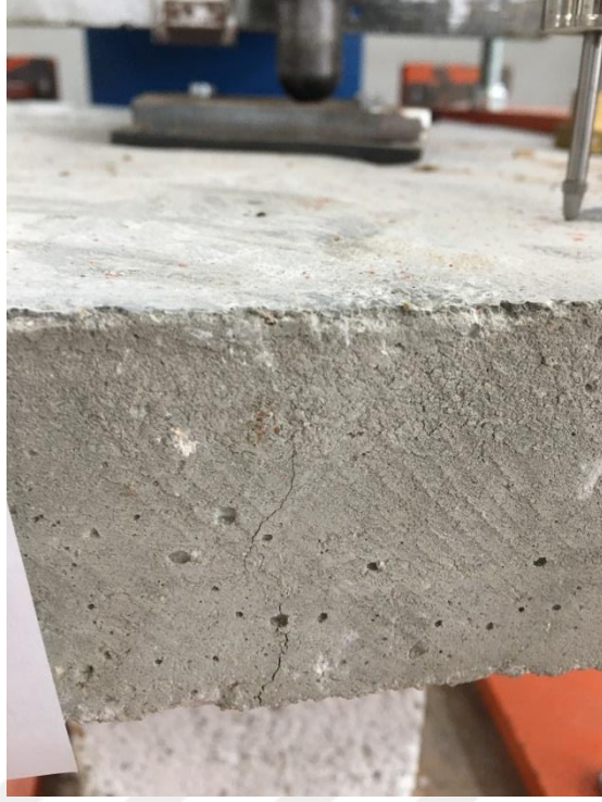
Şekil 7.13. P2-YS2 deney elemanında meydana gelen çatlaklar
