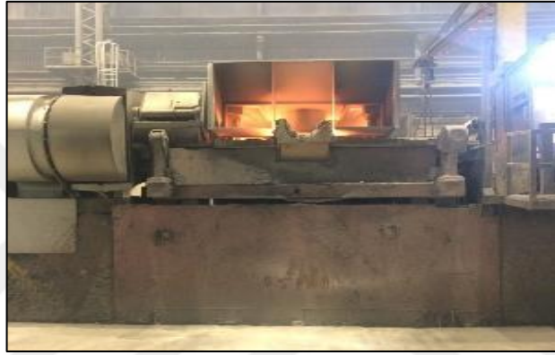
Şekil 3.3 : 14 ton kapasiteli indüksiyon ocağı
