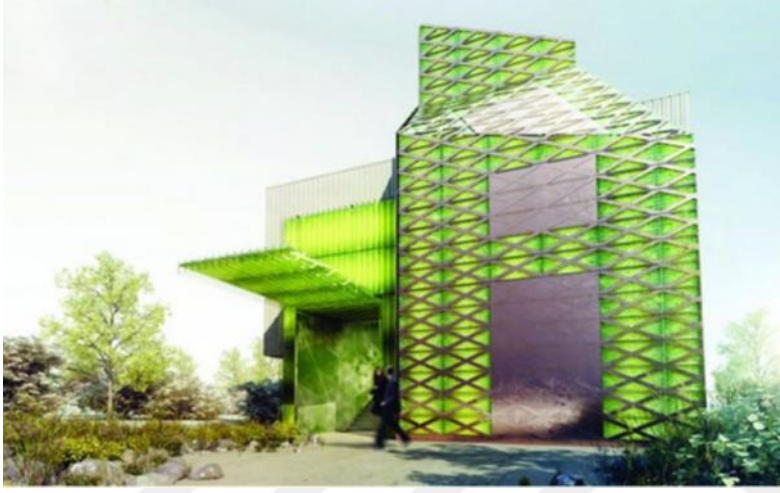
Şekil 2.29. Ennesys ve OriginOil işbirliği binası (Kükdamar,2017)
