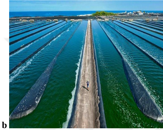
Şekil 2.24. Kapalı (a) ve açık (b,c) sistem alg üretim tesisleri (Anonim,2021a, Anonim,2021b, Anonim, 2021c).
