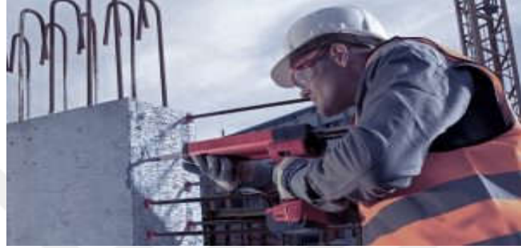
Şekil 8. Polimer malzemenin kolona enjekte edilmesi (Anonim 2021b)
