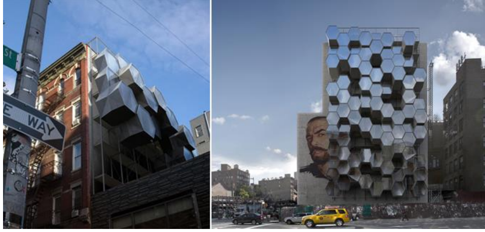
Şekil 15. Shelter with Dignity projesi
