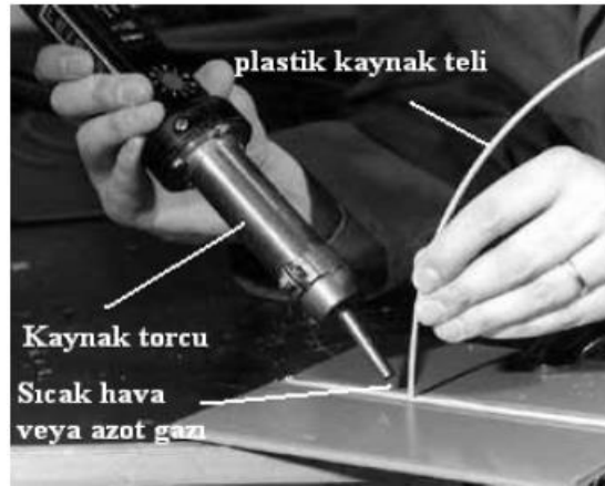
Şekil 3.2: Sıcak gaz kaynağı uygulaması [25]
