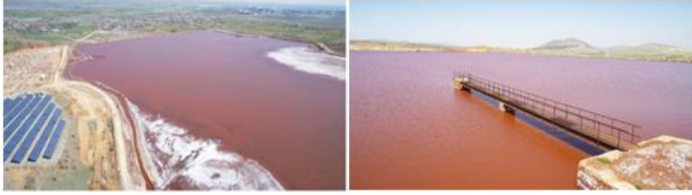
Şekil 11. Konya Seydişehir Eti Alüminyum fabrikası kırmızı çamur atık barajı (Web-kaynak-2).
