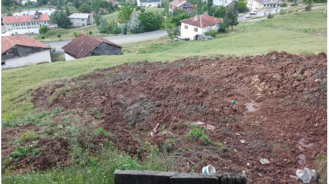
Şekil 2. 4 Çalışma alanında heyelan etkisinde kalmış yerleşim yerine bir örnek (AFAD, 2018).
