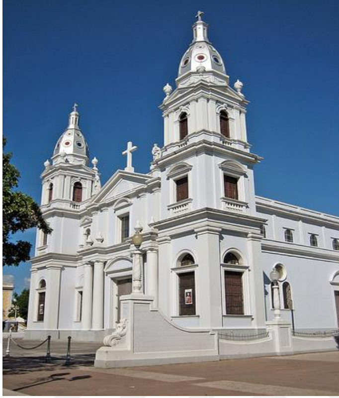
Şekil 69: 1579’da inşa edilen San Blas Kilisesi, Porto Riko. 388
