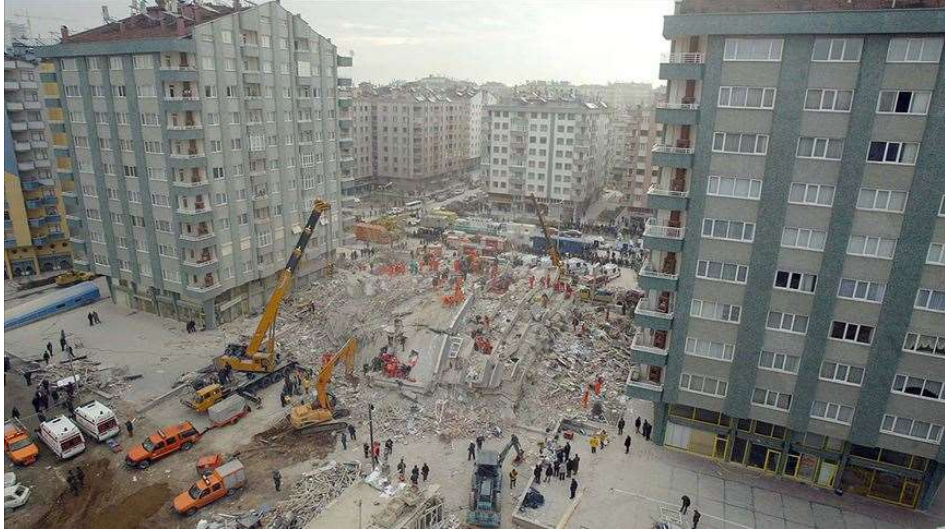
Resim 6. 1 Konya’da 2004 yılında yıkılan Zümrüt Apartmanı (Anadolu Ajansı, 2020)
